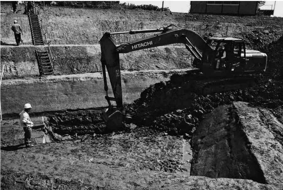
(2) 重機による深部掘削状況 (西から)
