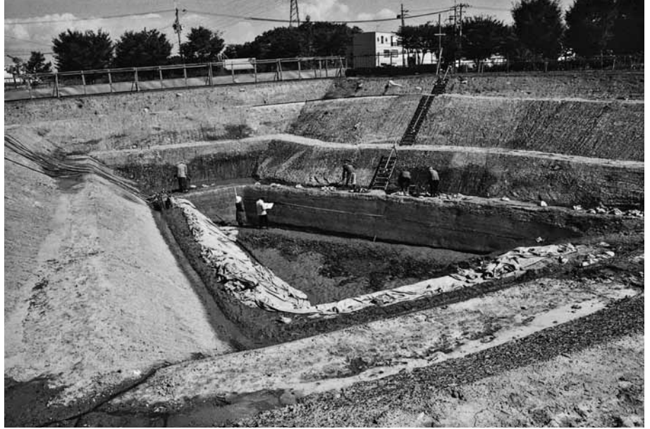
(1) 掘削作業状況(北東から)
