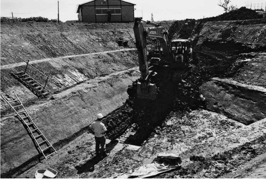
(1) 重機による深部掘削状況 (北西から)
