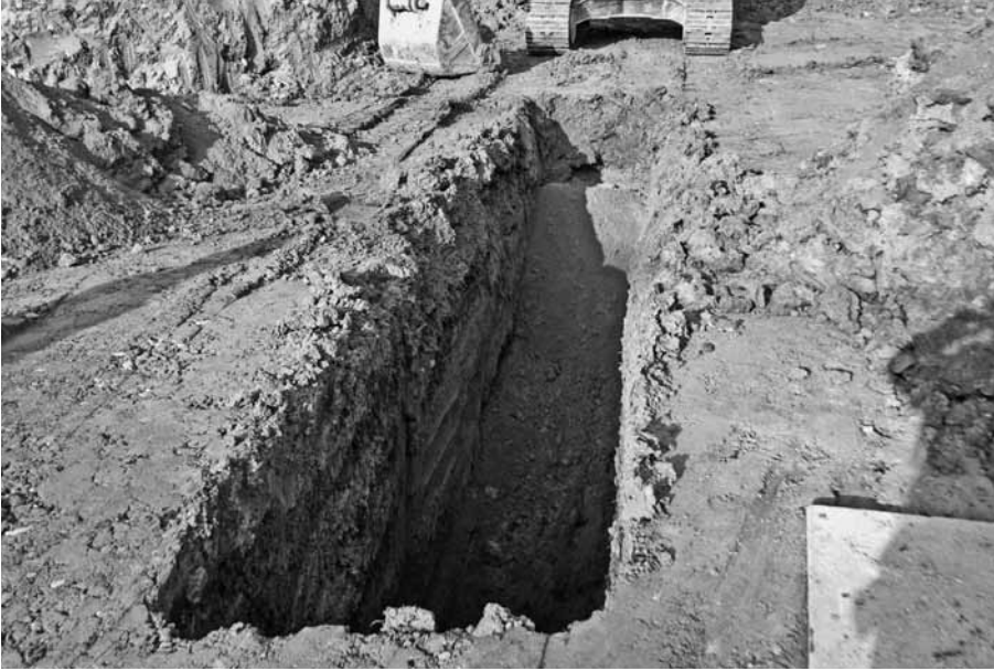
(1) C トレンチ掘削状況(北東から)
