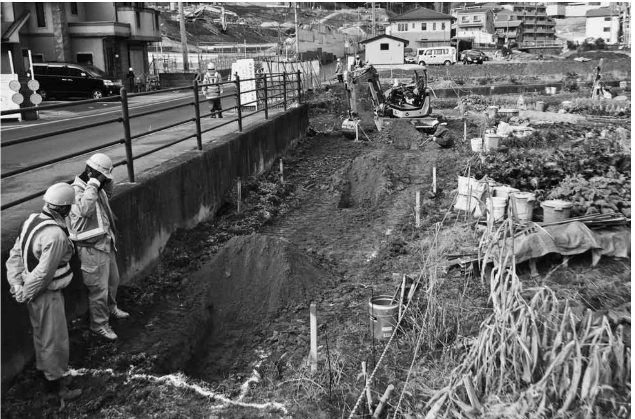
(2) 調査区近景(北東から)
