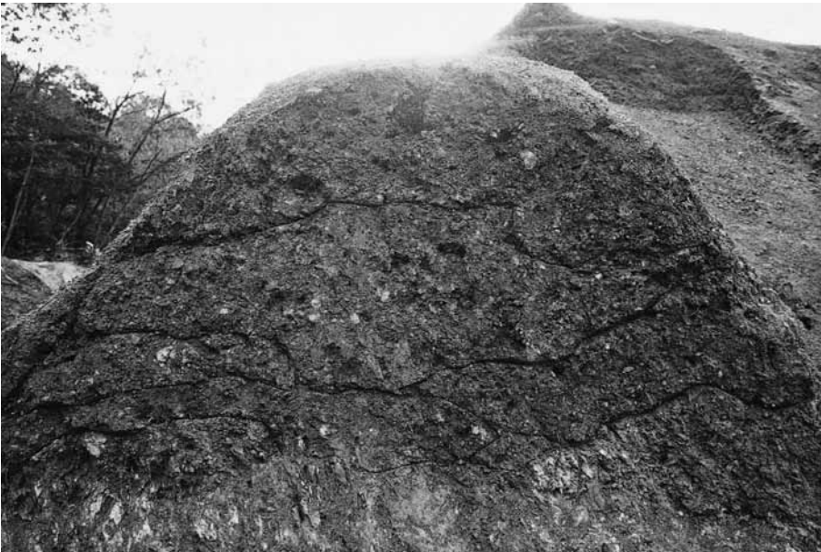
(2) 豎土塁 1 断ち割り (北西から)
