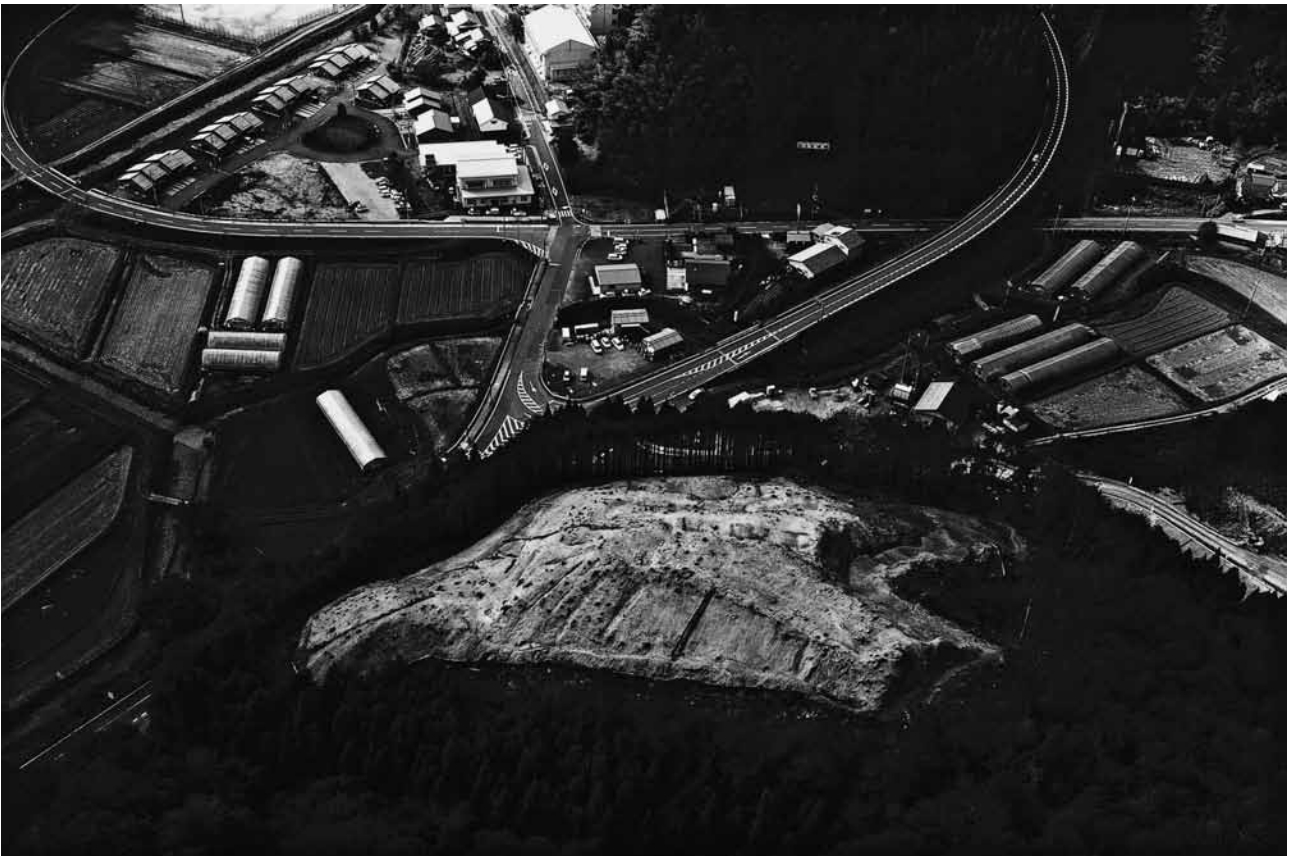
(2)同(空中写真、南東から)
