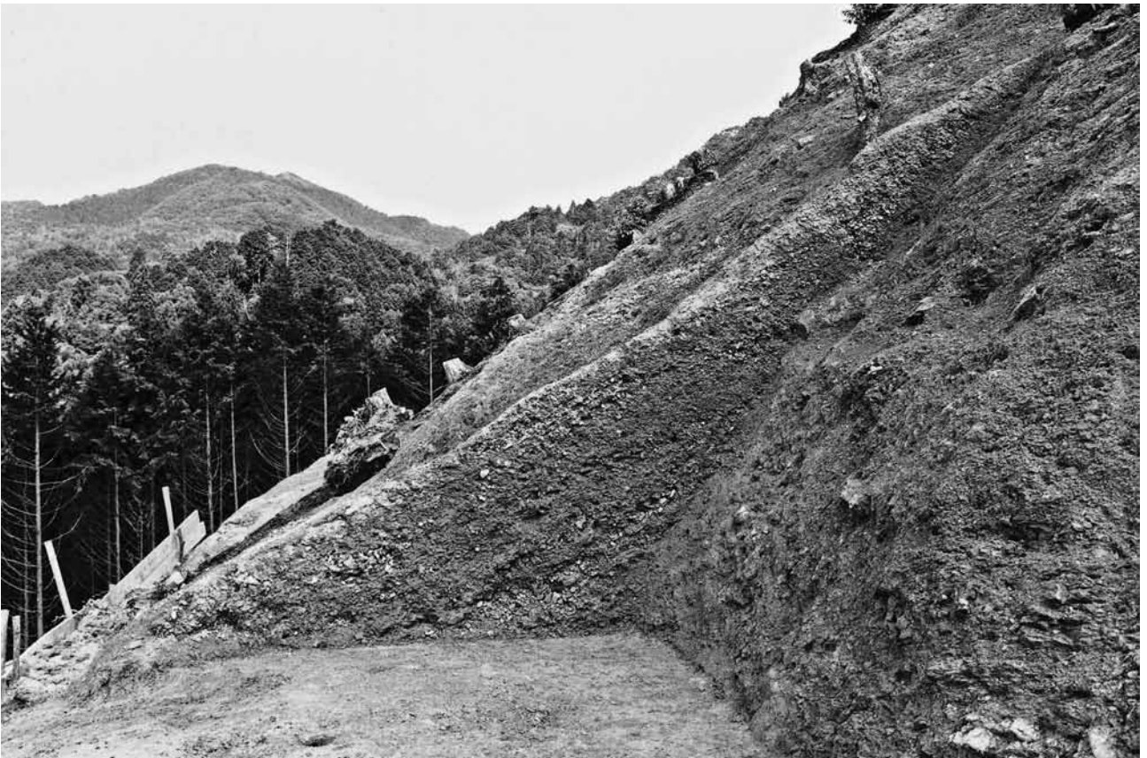
(2) 曲輪 6 切岸堆積土断面 (南東から)
