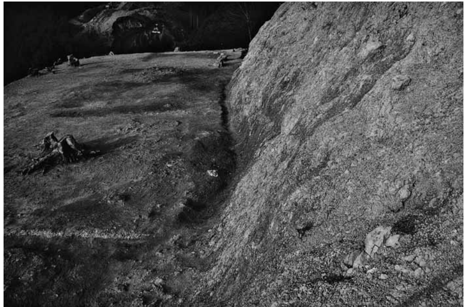
(2) 曲輪 3 切岸、排水溝(南西から)
