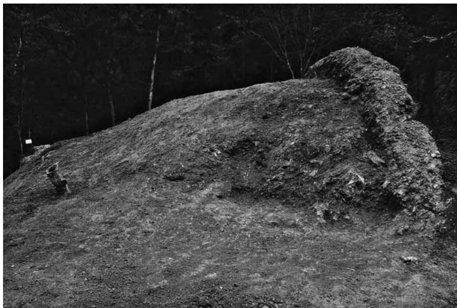
(1) 曲輪 1 土塁掘削状況(南西から)
