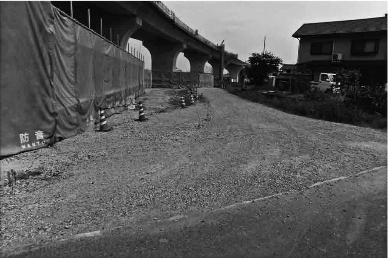
(1) 調査前の状況(北西から)
