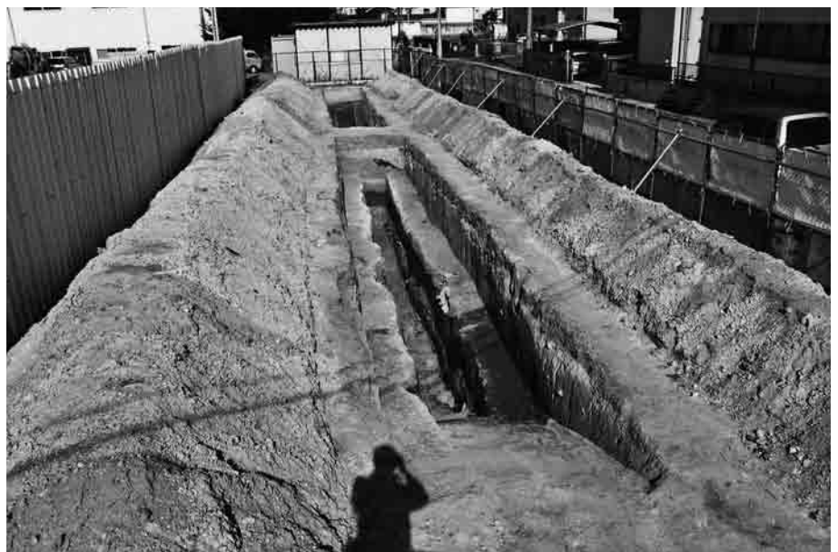
(3) 第 1 ・ 2 トレンチ全景(西から)
