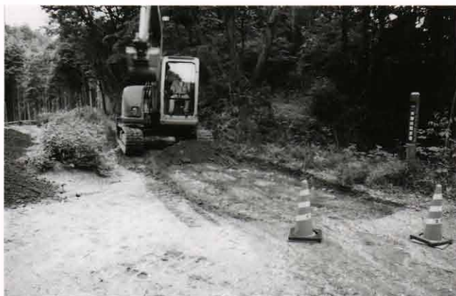
(1) 第 1 トレンチ重機掘削状況(北から)
