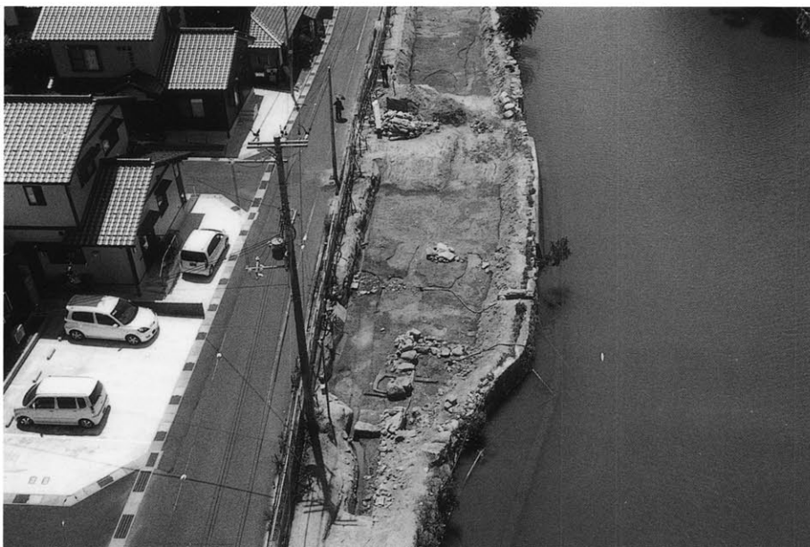
(2)14-1区全景(北北東から)
