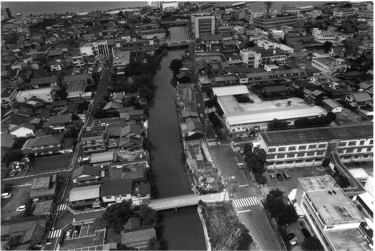
(1) 調査地全景(南南西から)
