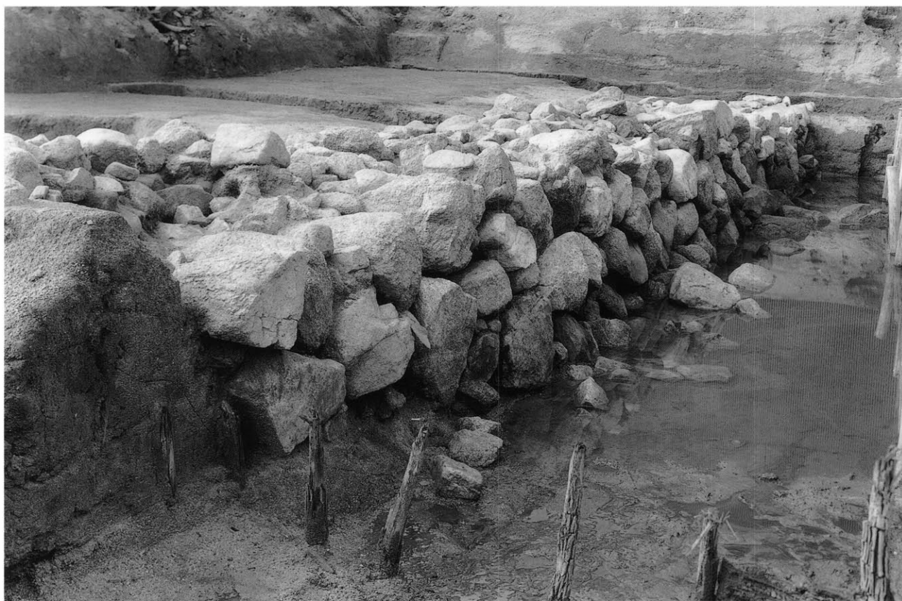
(2)13-2区石垣S X 201全景(南から)
