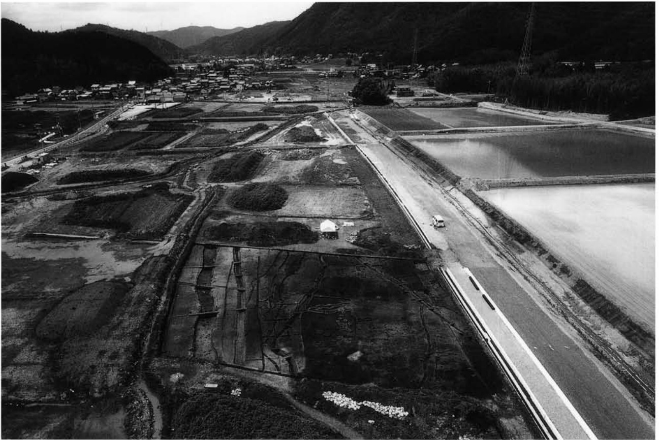
(1) 7区調査地全景(南から)
