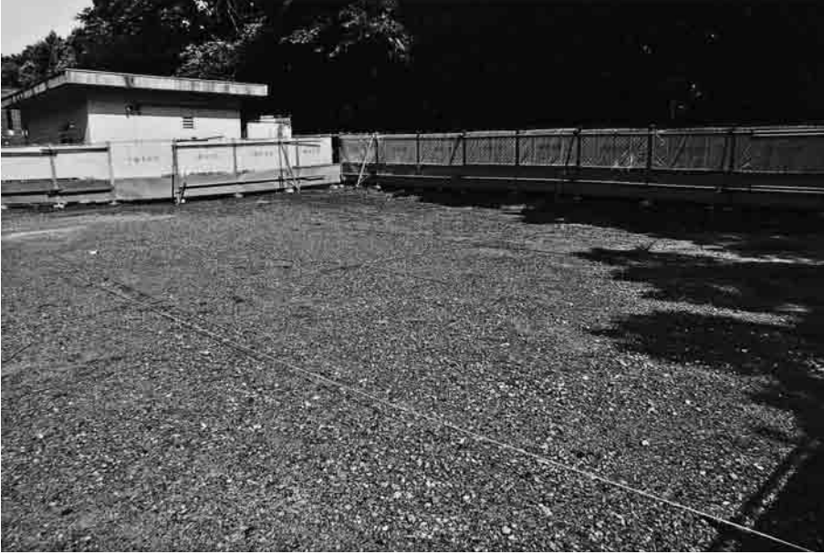
(1) 8区調査前状況(南東から)
