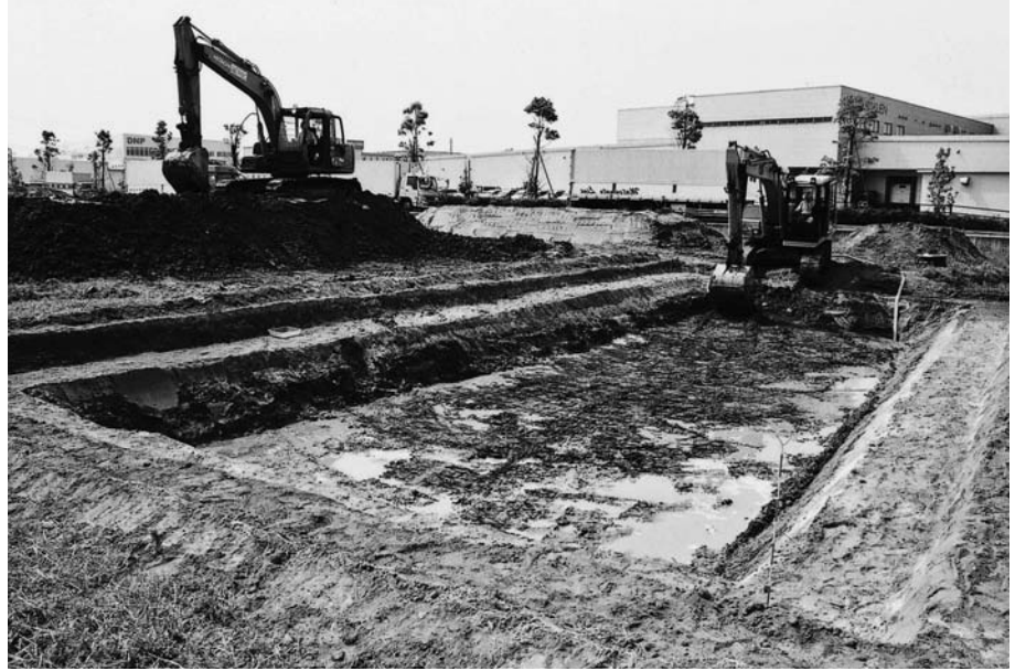
(1) I 区 4 トレンチ重機掘削 (南東から)
