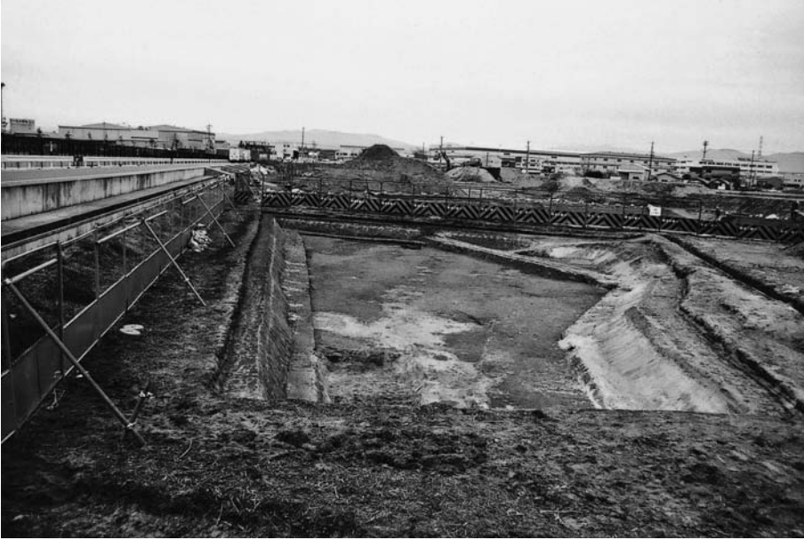
(1) Ⅲ区 3 トレンチ全景(西から)
