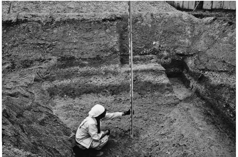
(2) 7トレンチ西辺断ち割り状況 (東から)
