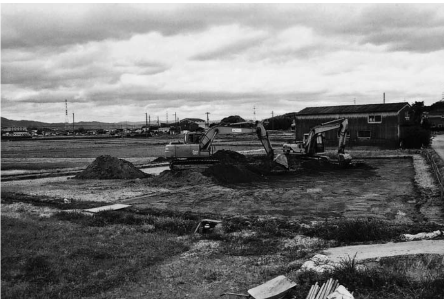
(3) Ⅲ区 4 トレンチ重機掘削 (北西から)
