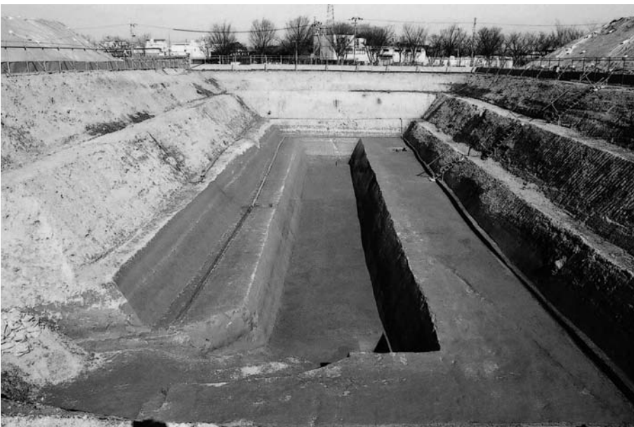
(3) 1 トレンチ最下層掘削状況全景 (南から)
