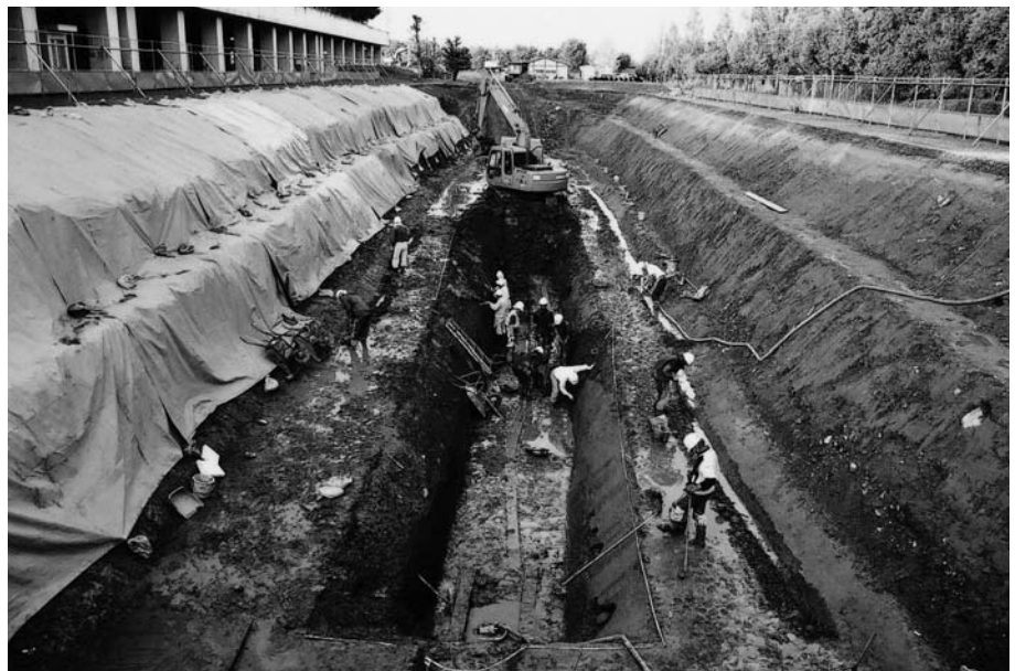
(3) 2 トレンチ作業状況(南から)
