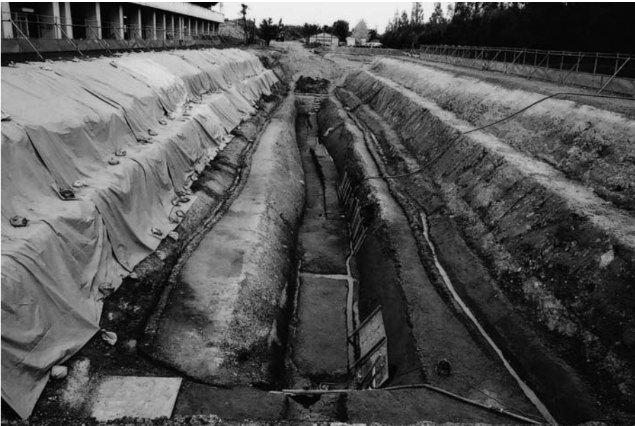
(2) 2トレンチ全景(南から)
