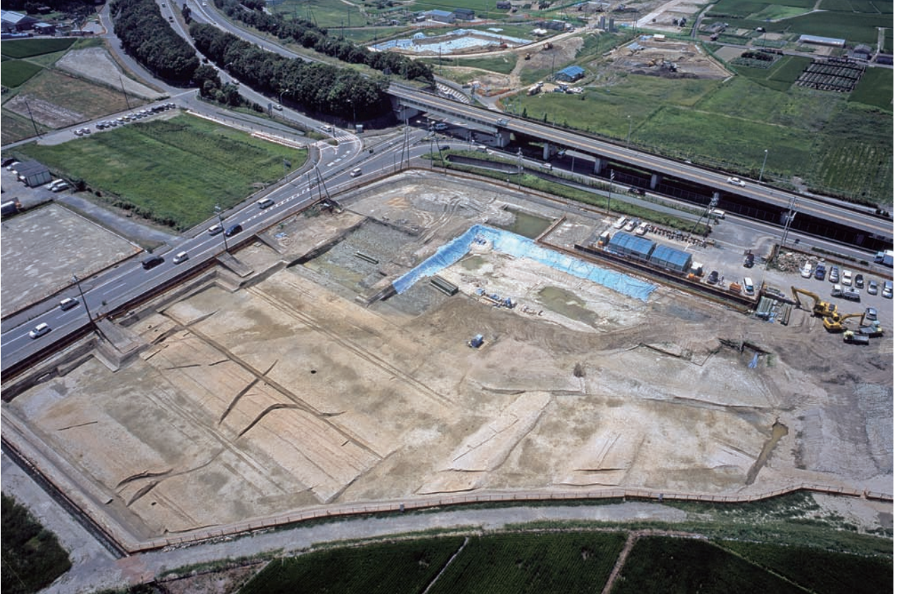
(1) D 地区全景 (北東から)
