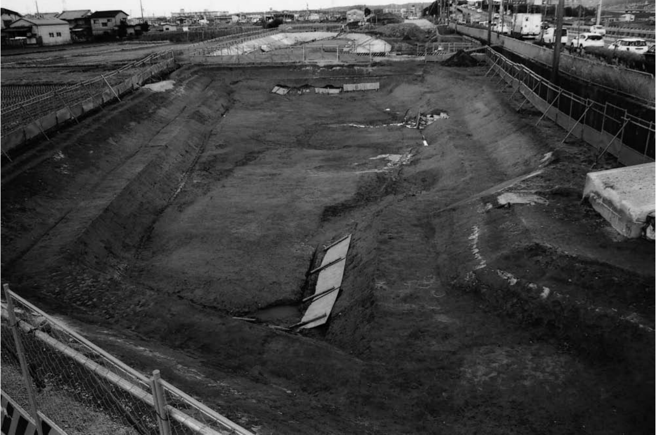
(1) A 地区全景 (北から)
