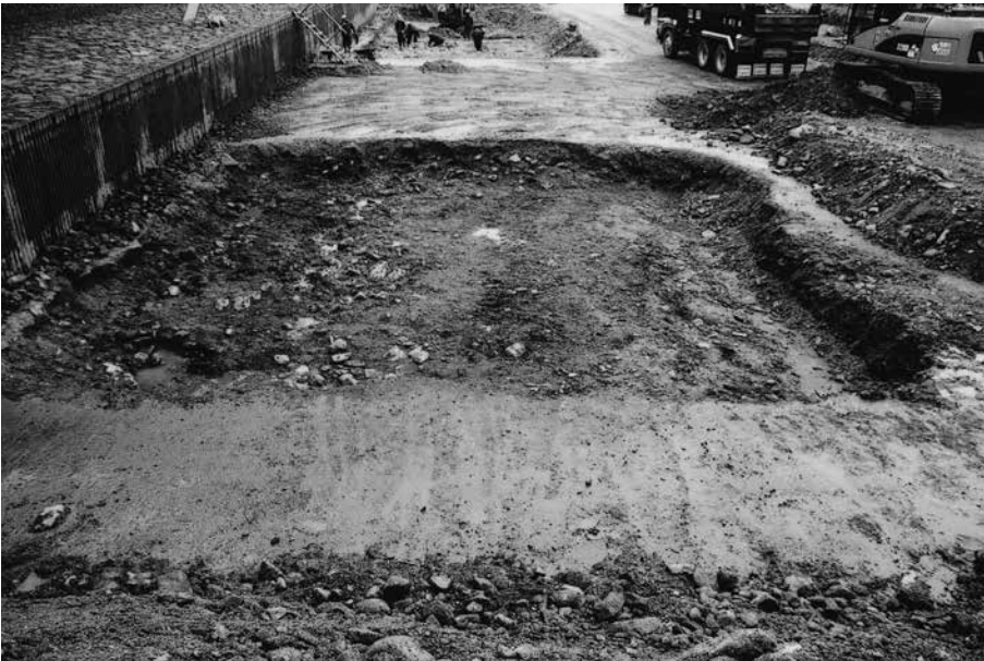
(2)26-3 トレンチ全景(南東から)
