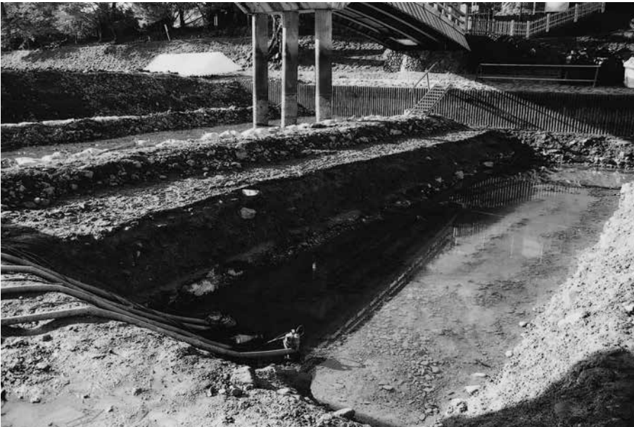
(2)24-1 トレンチ断面(北から)
