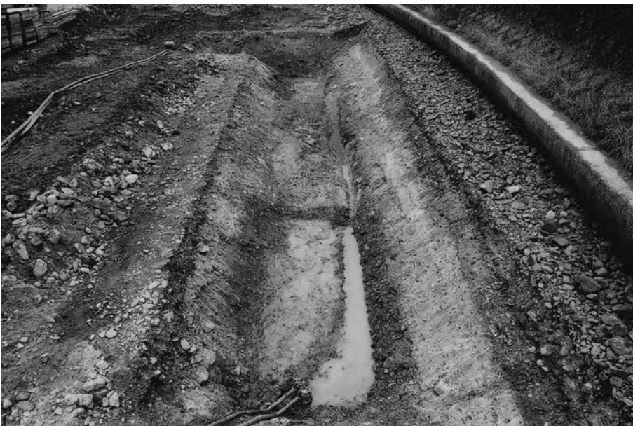
(3)24-2 トレンチ完掘後全景 (北西から)
