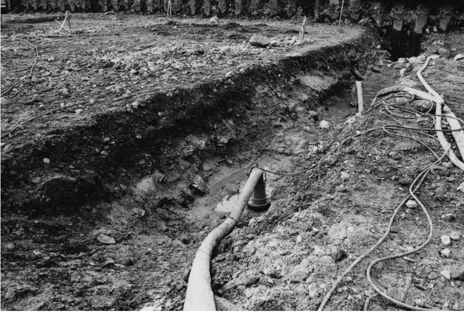
(1)25-1 トレンチ全景(北東から)
