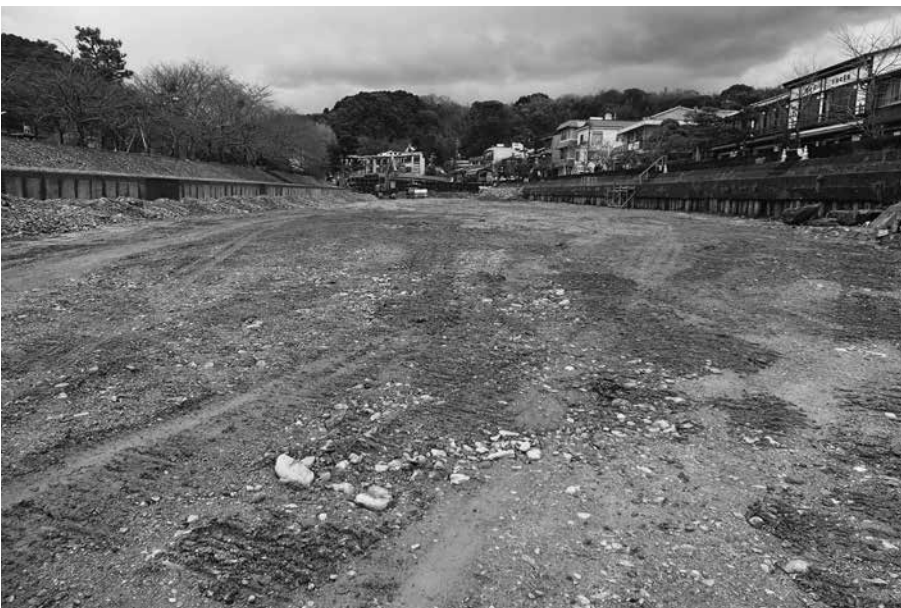
(3)平成26年度調査終了状況 (北西から)
