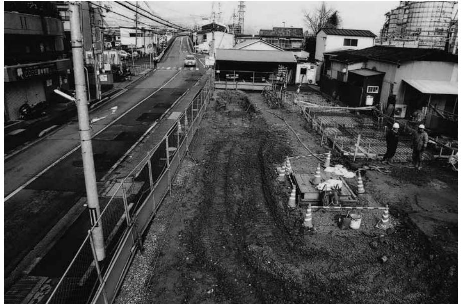
(1) 調査地北部掘削前状況(南から)
