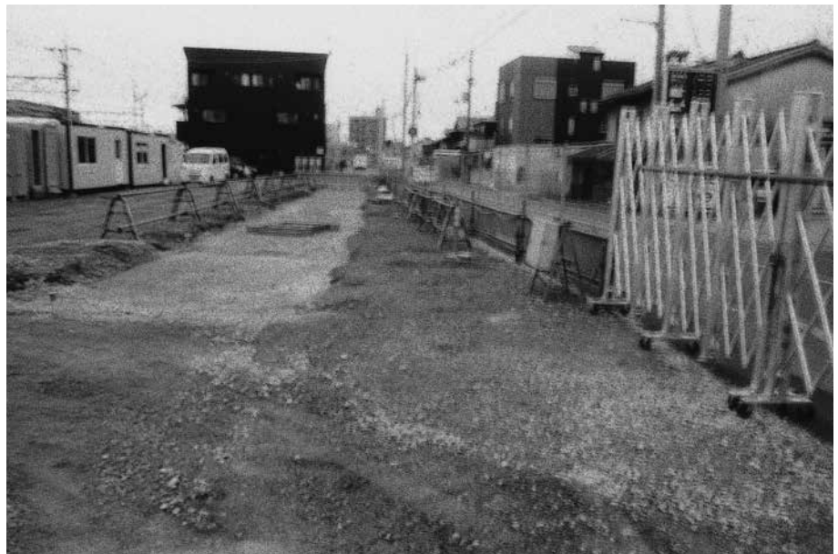
(2) 調査地中間～南部掘削前状況 (北から)
