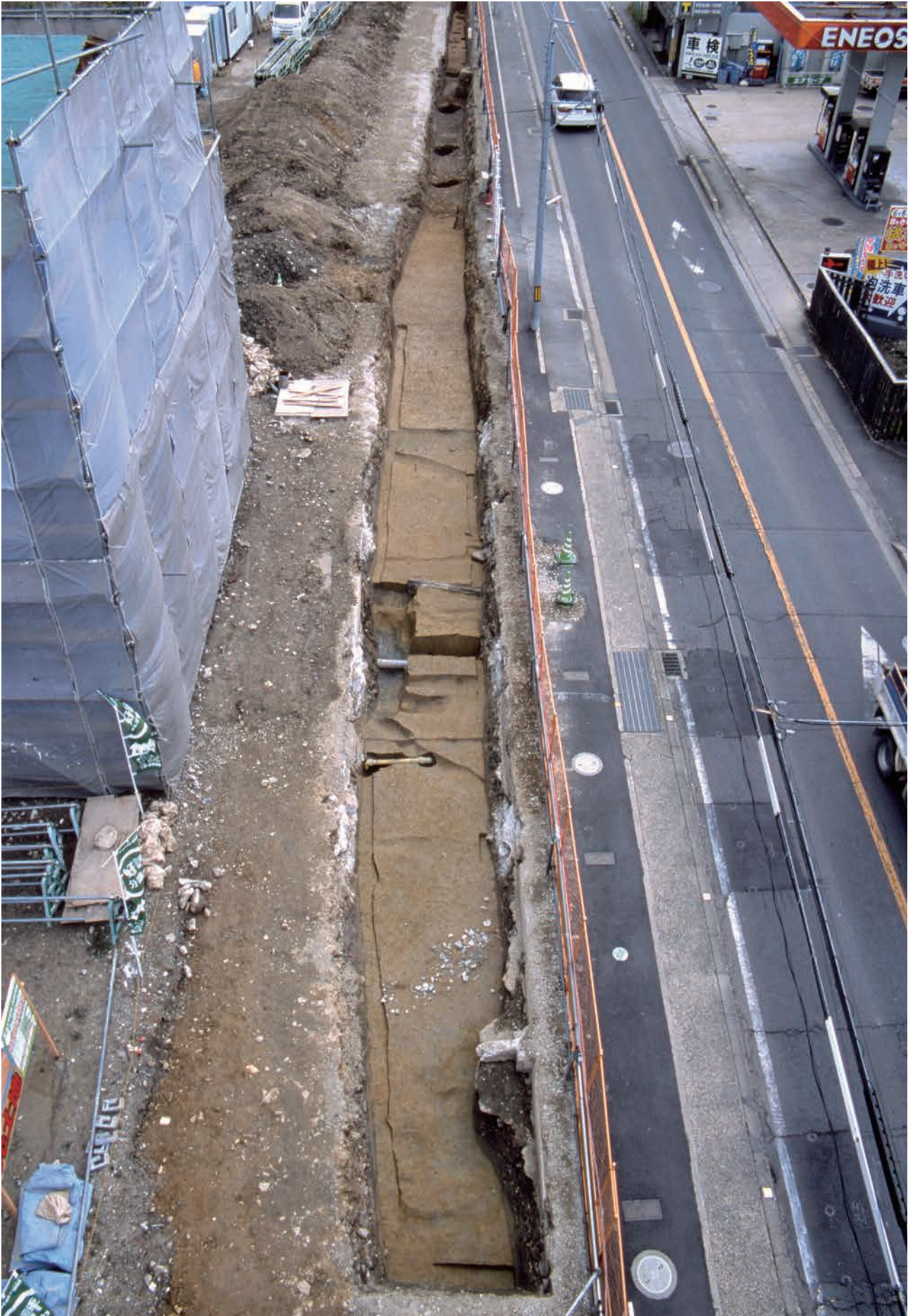
調査地全景(北から)
