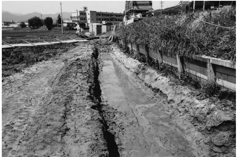
(2)トレンチ掘削状況(北東から)
