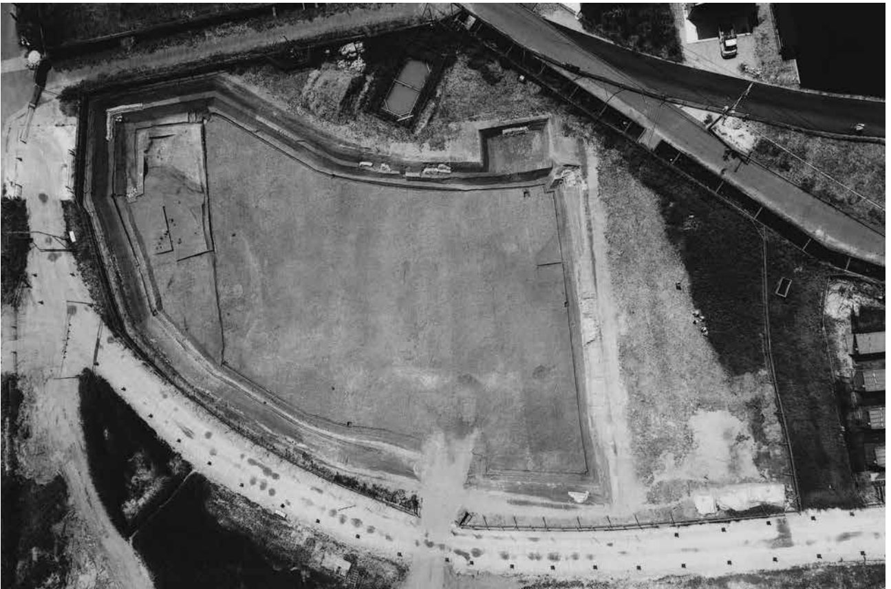
(2) D 2 区全景 (上が南)
