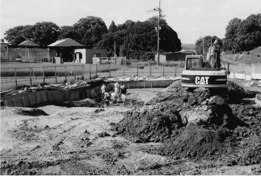
(1) B 2 区重機掘削(北から)
