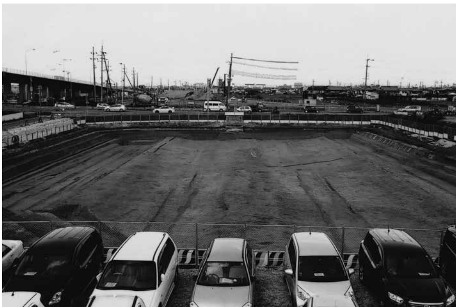
(1) A3区島畑27～29全景 (南から)
