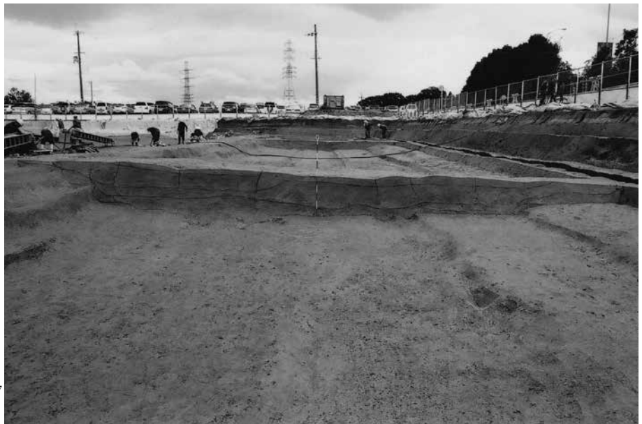
(2) A 3 区島畑29土坑状遺構 S K 07 g - h 土層断面(北から)
