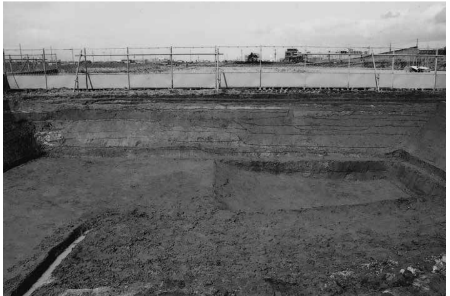
(2) E 2 区北壁土層断面(南から)
