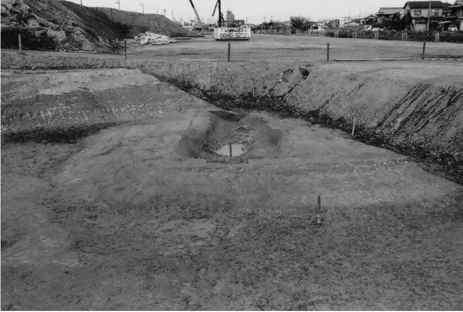
(1) C 2 区島畑 7 全景(南から)
