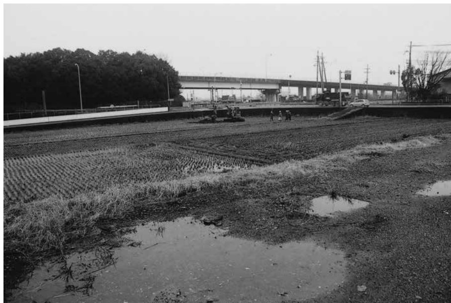
(1) A 1 区重機掘削(南東から)
