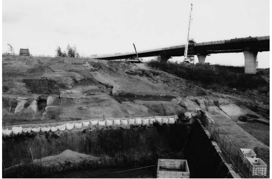
(1) 6 トレンチ遠景(南から)
