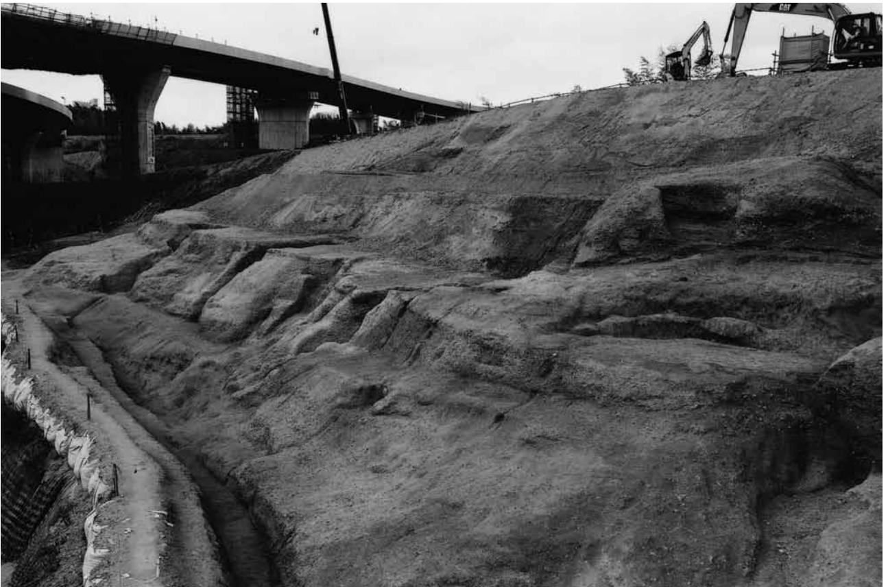
(2) 48・49・50号横穴天井部掘削後遠景(北東から)
