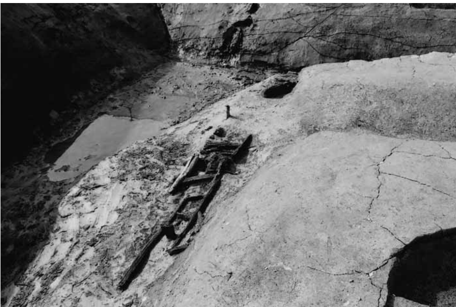
(3) F 6 区溝 S D0601 護岸施設 (北半部) 検出状況 (南東から)
