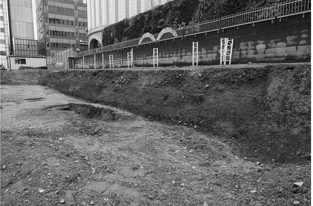
(1) 第3調査区南壁土層断面(北西から)
