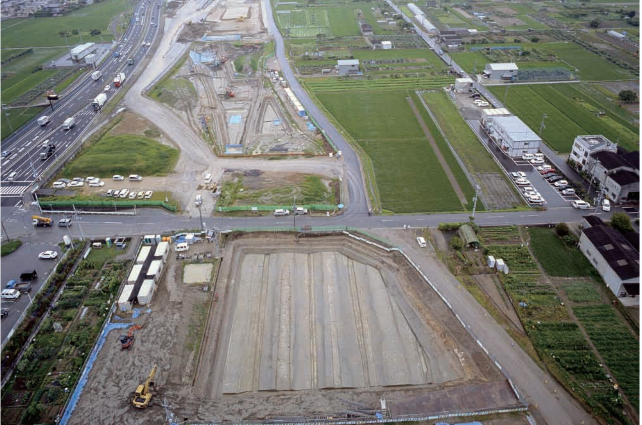
(1) 下水主遺跡第 8 次 O 1 区全景 (北から)
