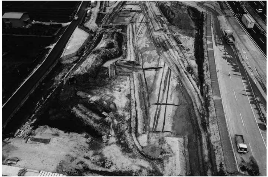
(1) L 2 ・ M 2 区全景(南から)
