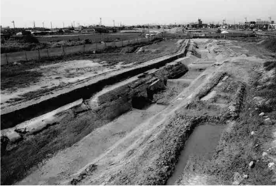
(1) I 地区全景(南から)
