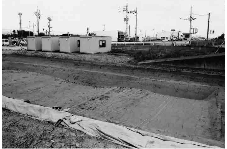
(1) N 地区北壁土層断面(南東から)
