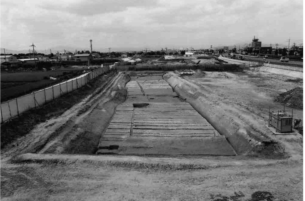
(1) K 1 区島畑64・65全景(南から)
