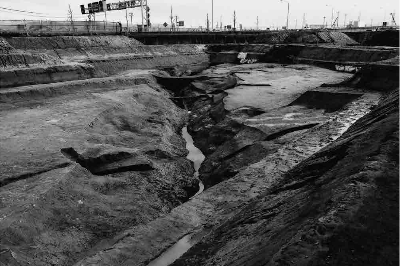
(1) J 地区溝 S D04 全景 (北西から)
