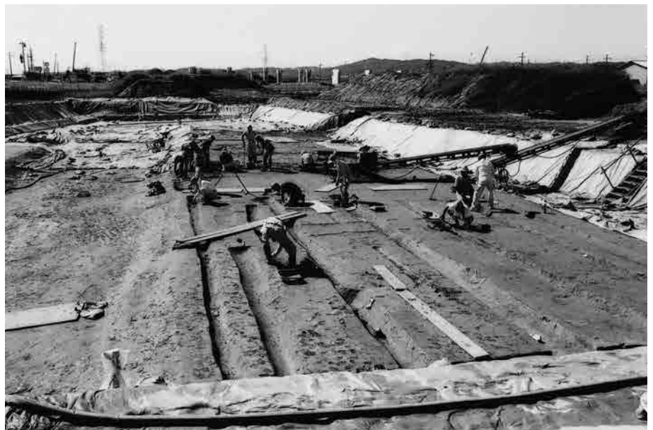
(3) N地区作業風景(北から)
