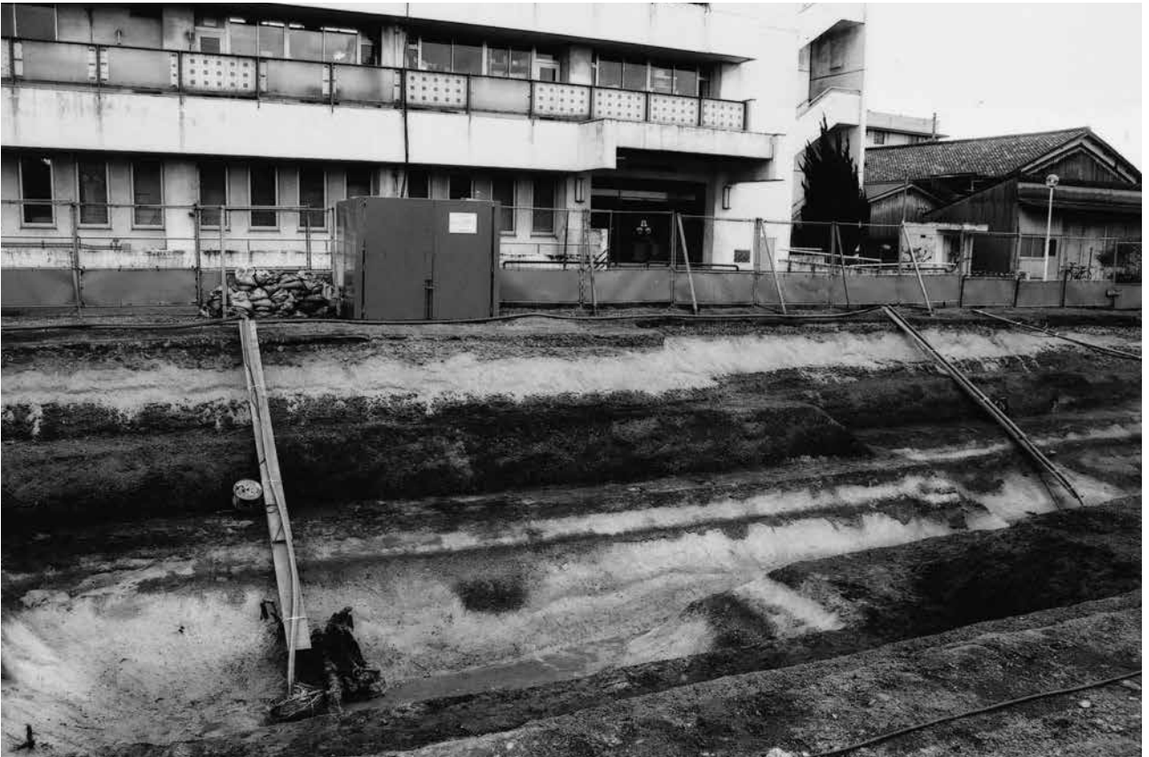
(2) 第1トレンチ南壁断面(北東から)
