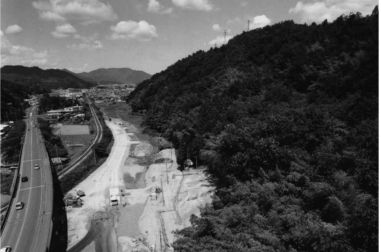
(1) 3トレンチ 完掘状況遠景(南から)
