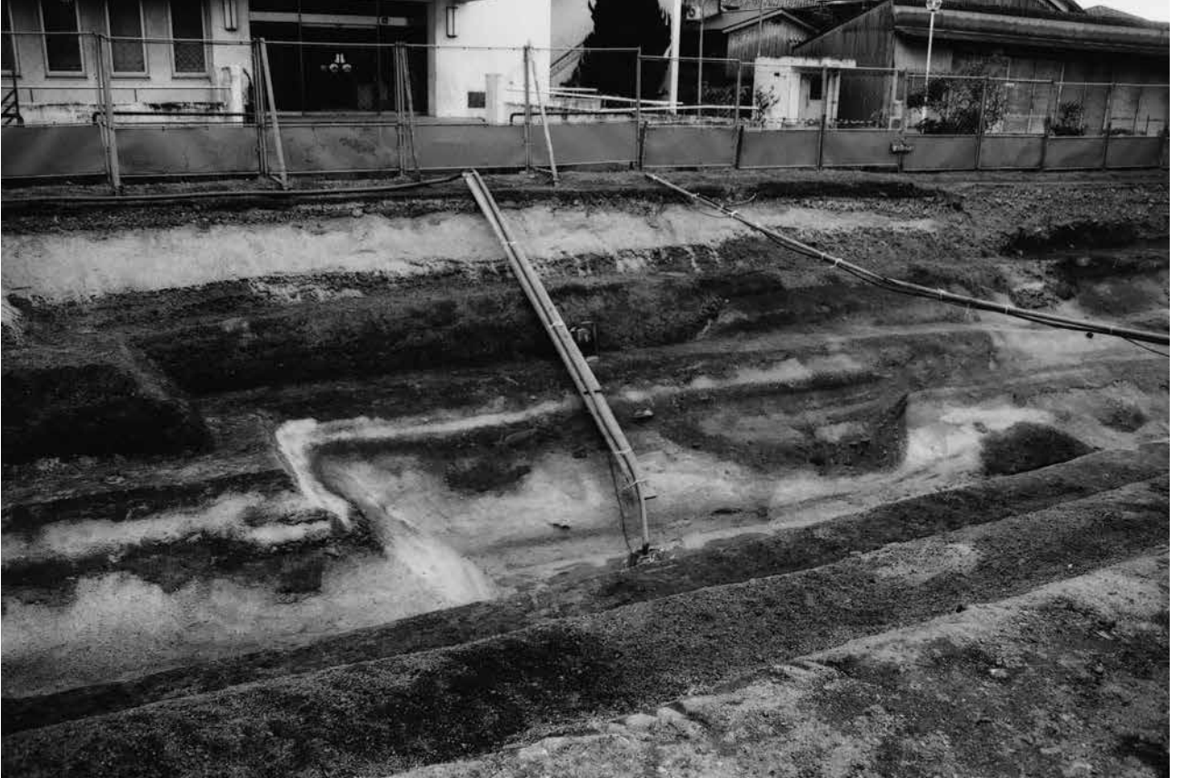
(1) 第1トレンチ南壁断面(北東から)
