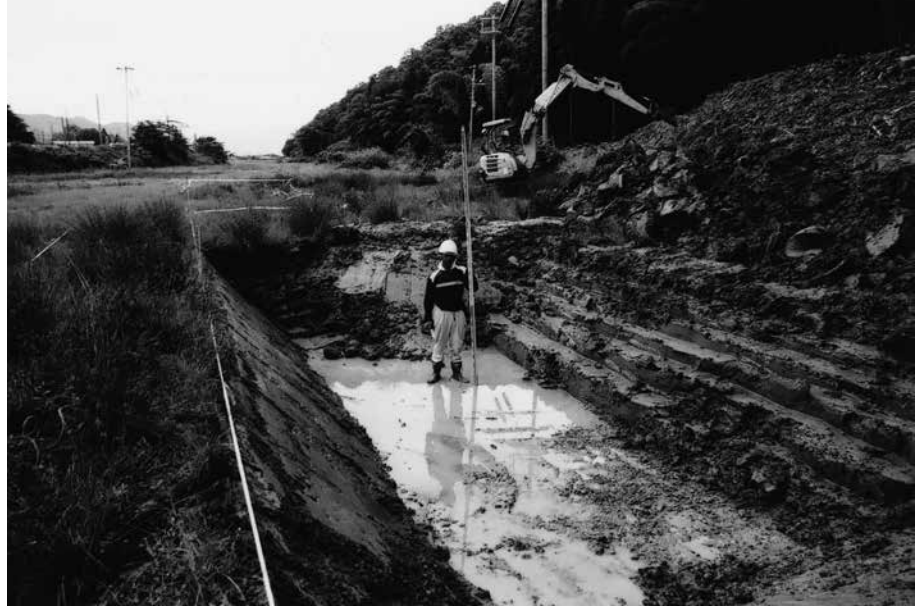
(1) 1 トレンチ 重機掘削状況 (南から)
