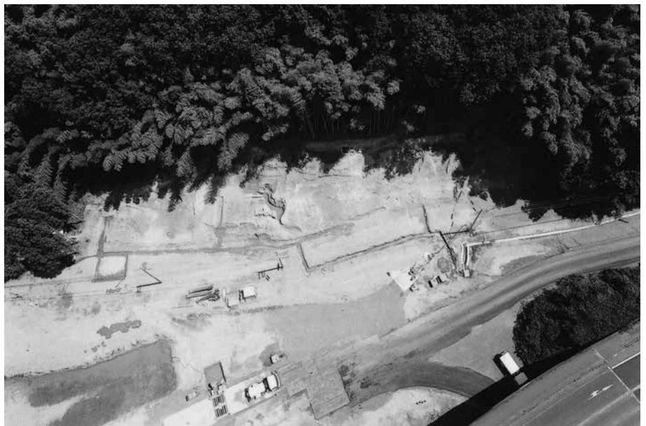
(3) 3トレンチ 完掘状況(西から)
