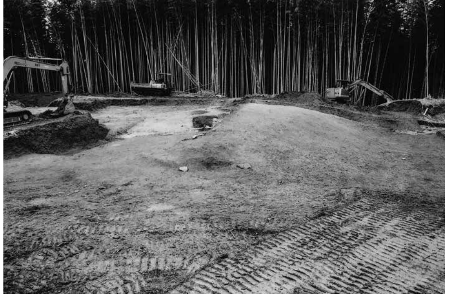
(1) 2トレンチ1号墳検出状況 (南から)
