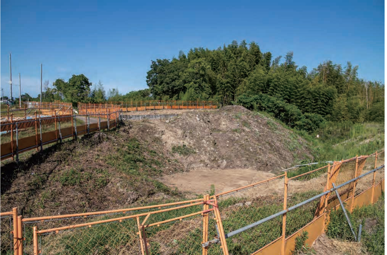
(1) 東端調査区調査前全景(南から)
