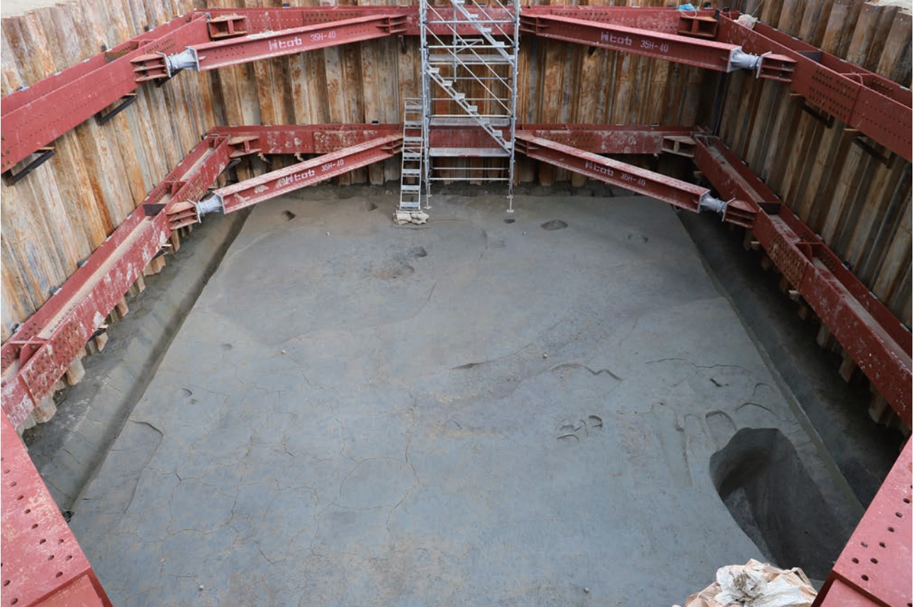
(1) F17区中世面完掘状況(西から)
