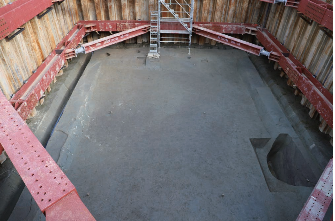
(1) F17区基盤層面完掘状況(西から)
