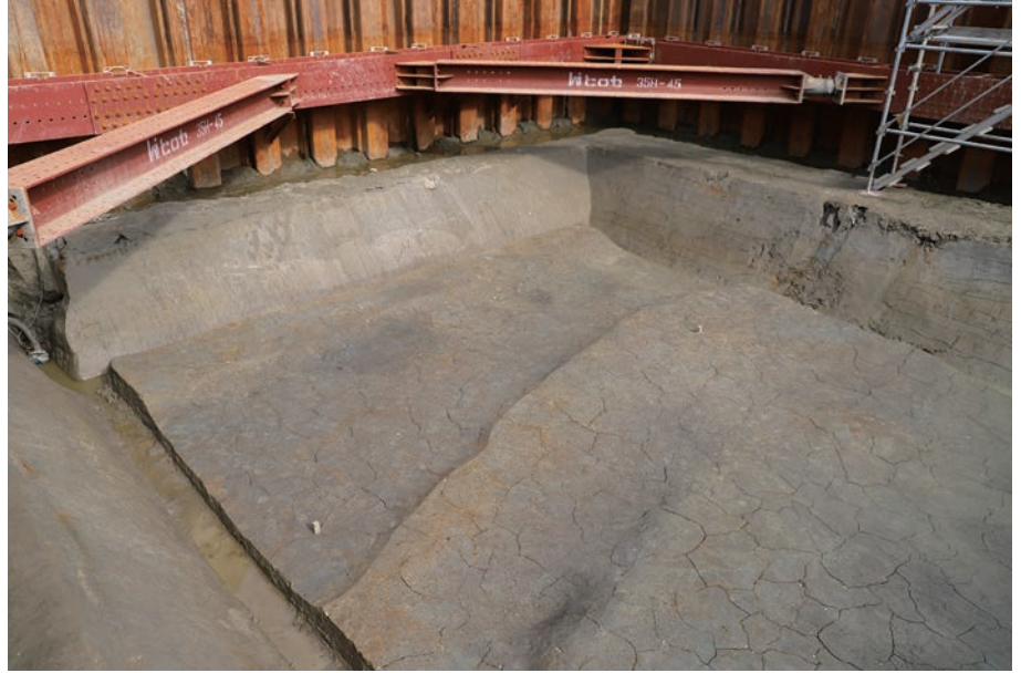
(1) F14区 S D1402完掘状況 (北西から)
