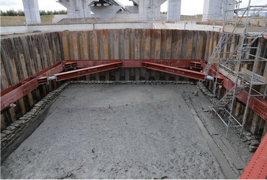
(1) F13区 S D1302検出状況 (東から)
