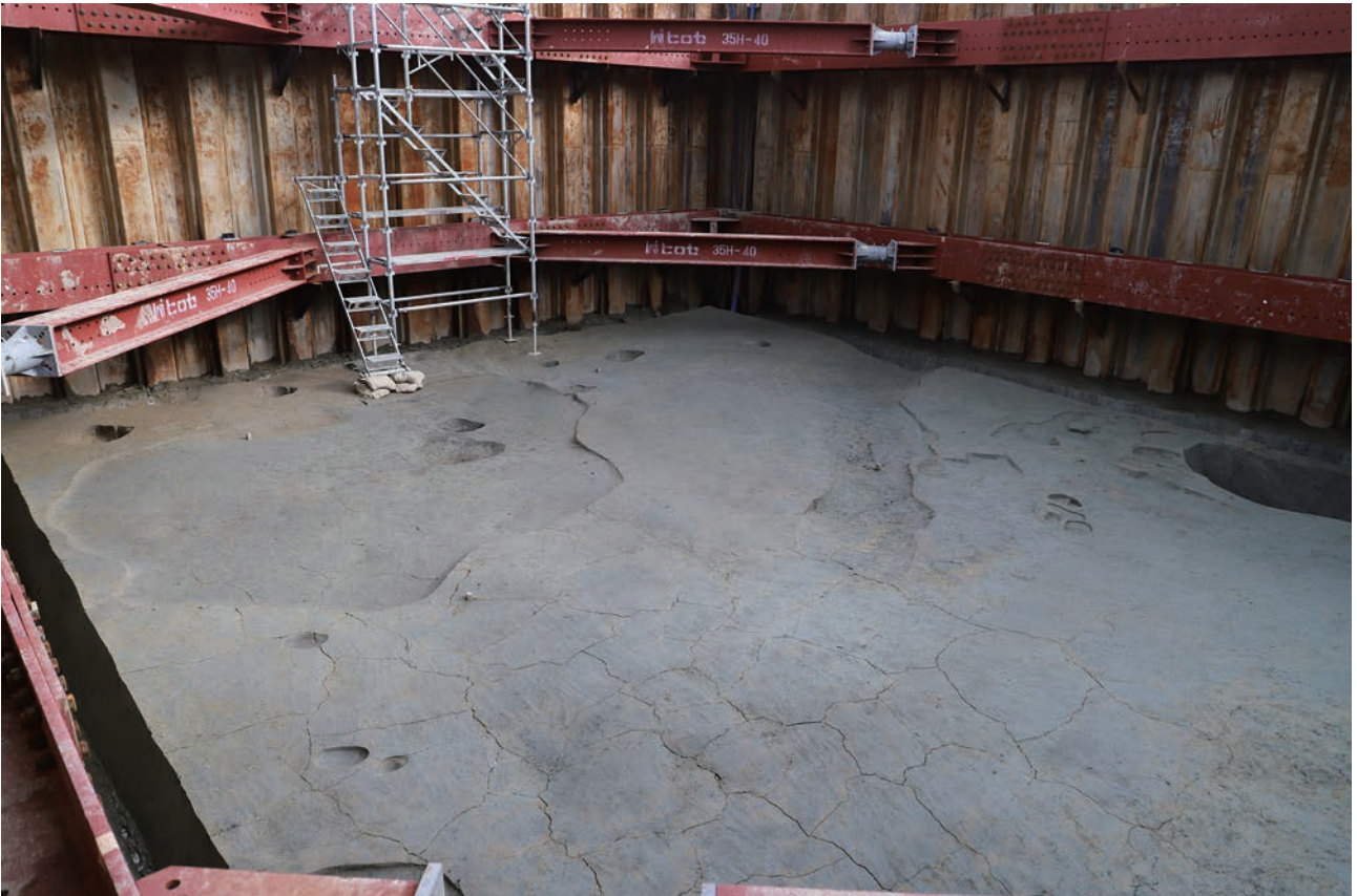
(2) F17区中世面完掘状況(北西から)
