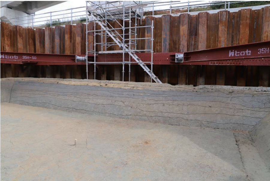
(2) F16区北壁土層断面 (北西から)
