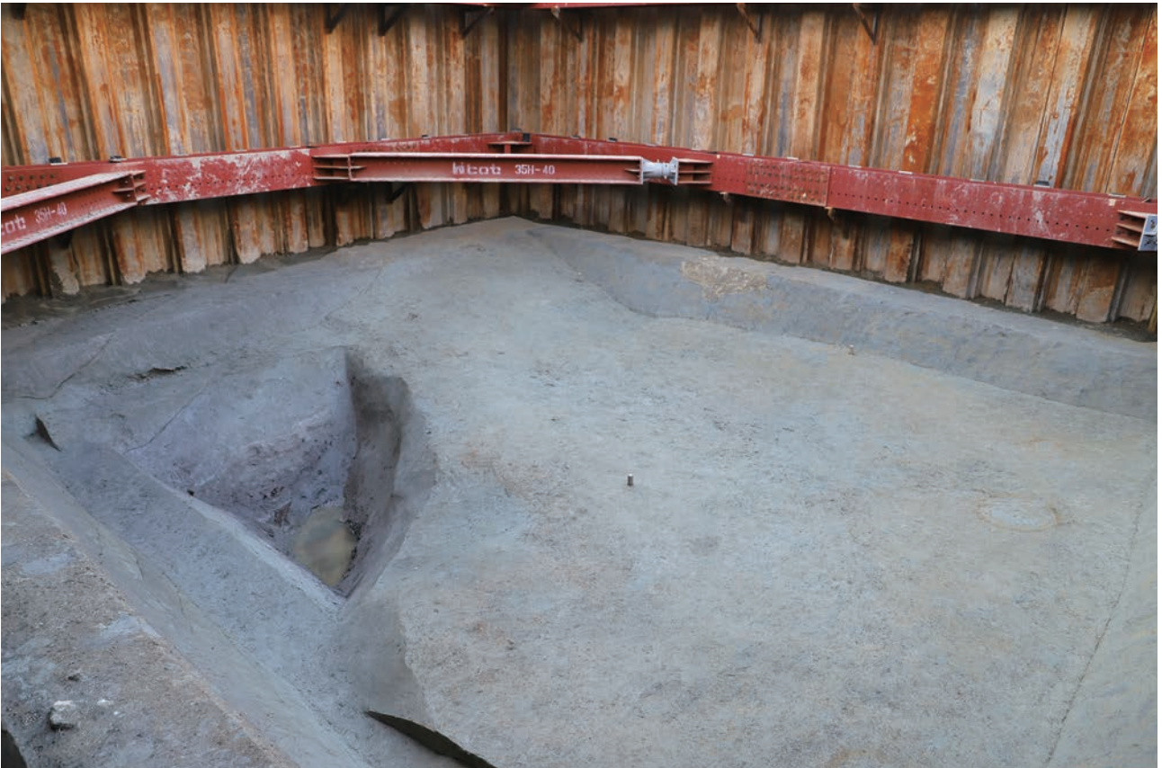
(2) F18区基盤層面完掘状況(南東から)
