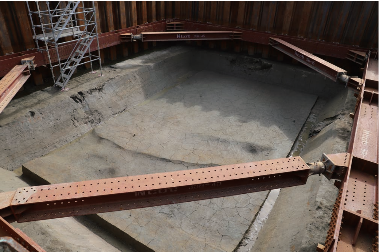
(2) F14区完掘状況(北東から)
