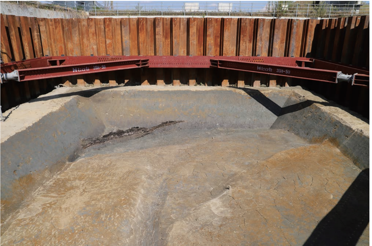
(2) F15区完掘状況(西から)
