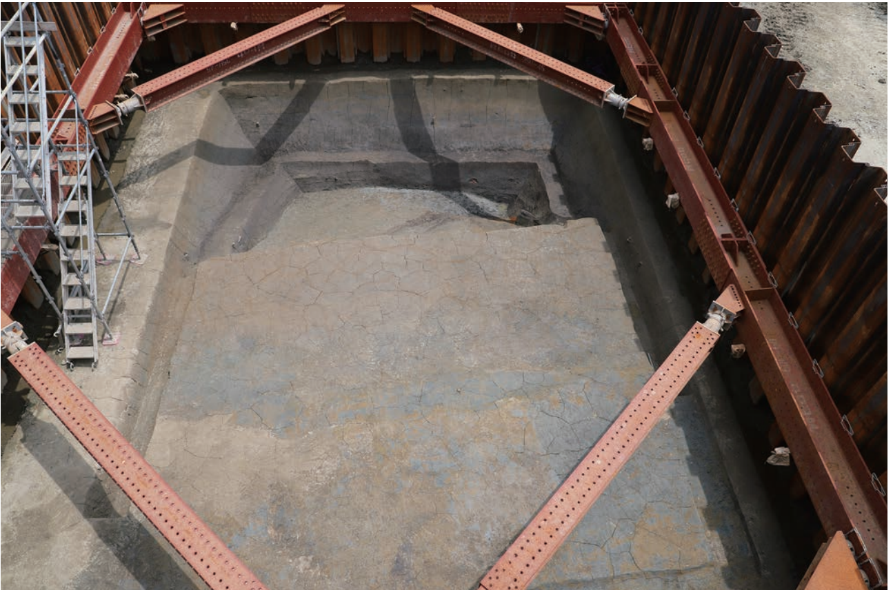
(2) F13区基盤層面完掘状況(西から)
