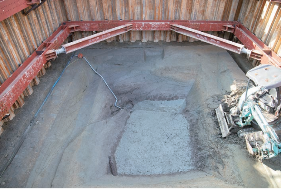
(1) F18区下層調査完掘状況 (北から)
