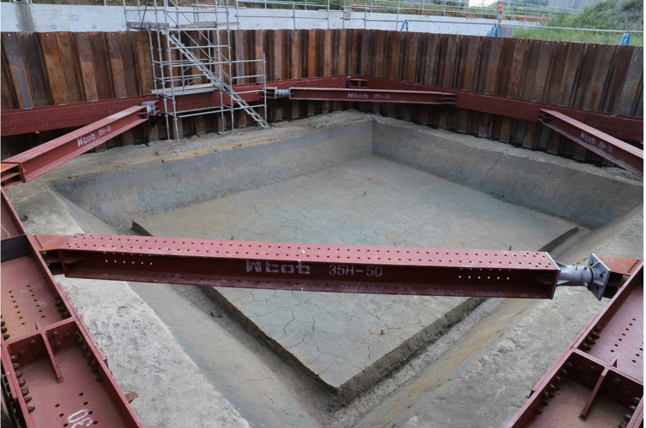
(1) F16区完掘状況(北東から)
