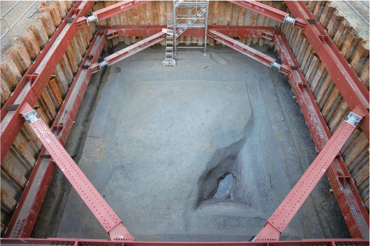
(1) F18区基盤層面完掘状況(西から)
