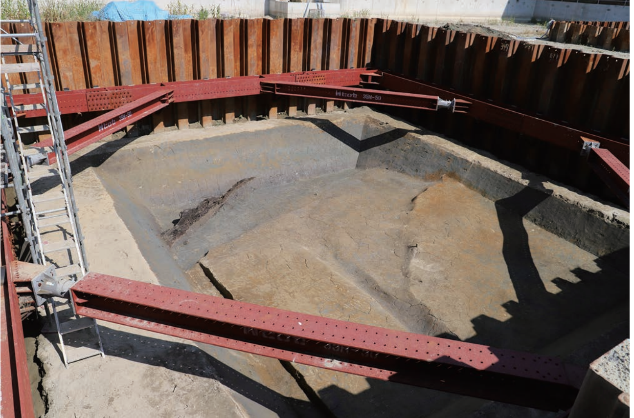
(1) F15区完掘状況(北西から)
