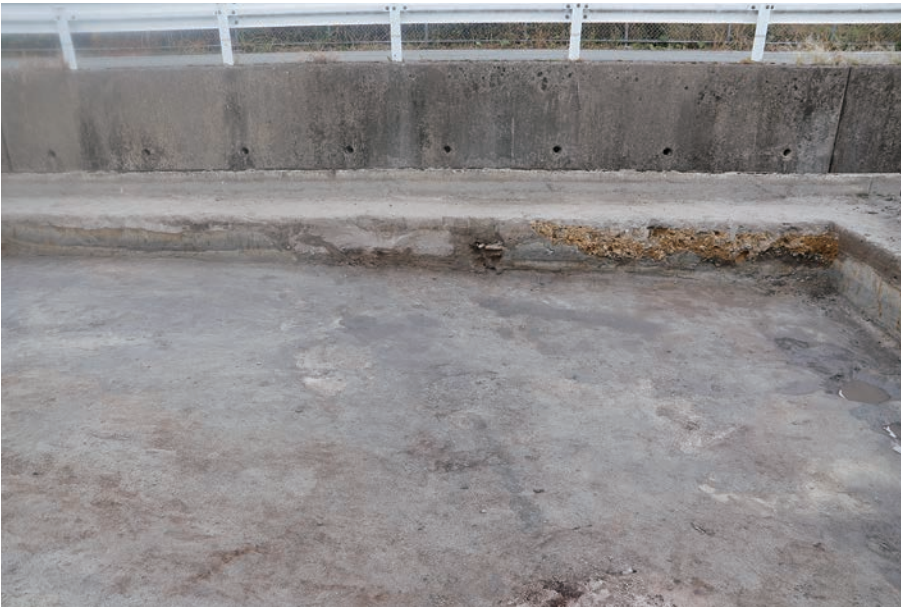
(2) NR 4 東壁断面 (西から)
