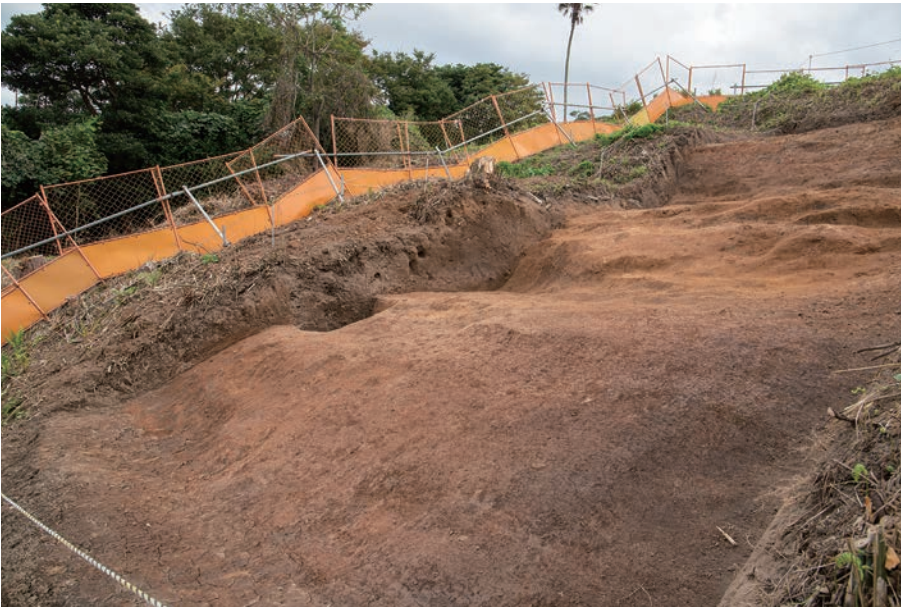
(2) 2区壁面(西から)
