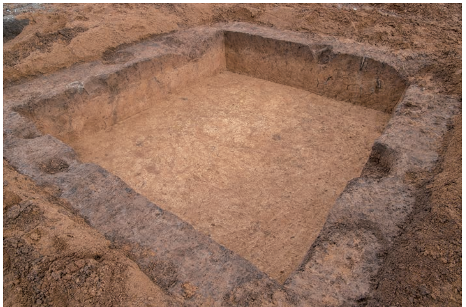
(3)下層確認トレンチ8完掘状況 (南から)
