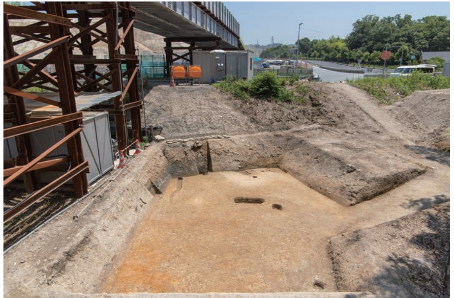
(2) X-1区調査トレンチ全景 (西から)
