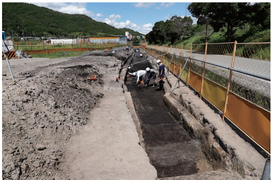
(3) 遺構検出作業状況(南東から)
