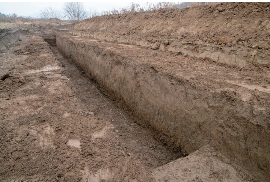
(3) 2区断ち割り(北から)
