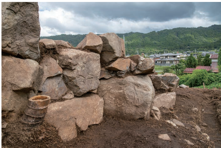
(2) 20号墳石室上部袖部検出状況 (北西から)
