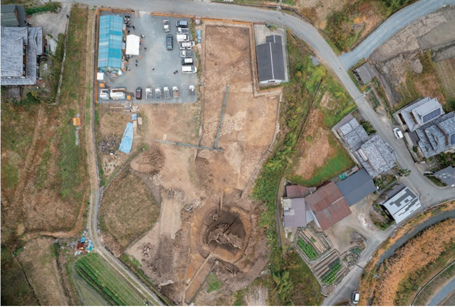
(1) 調査地全景(上が北東)
