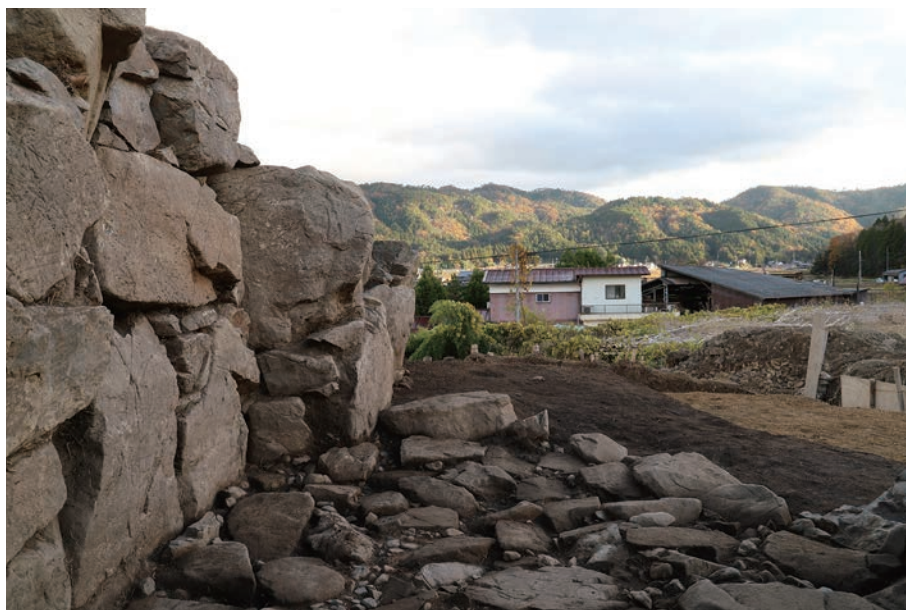
(2)20号墳袖部・羨道検出状況 (北西から)
