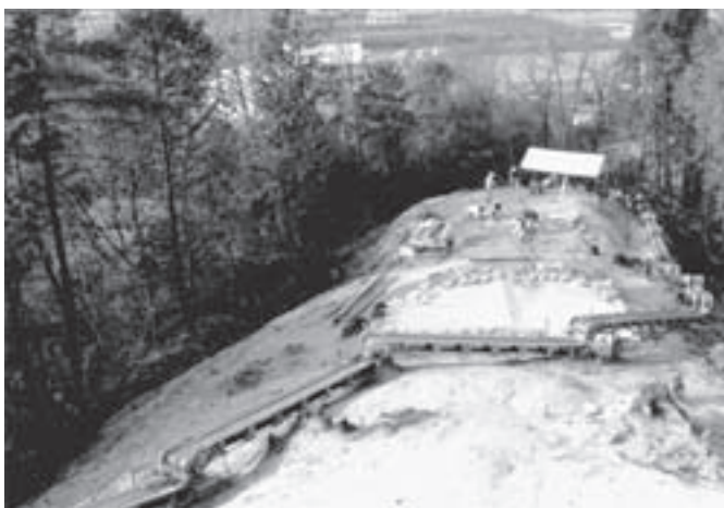
第3図 土留め柵設置状況
