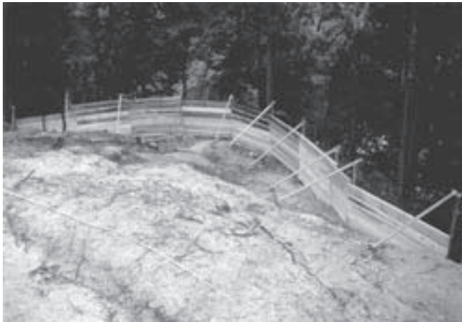
第3図 土留め柵設置状況
