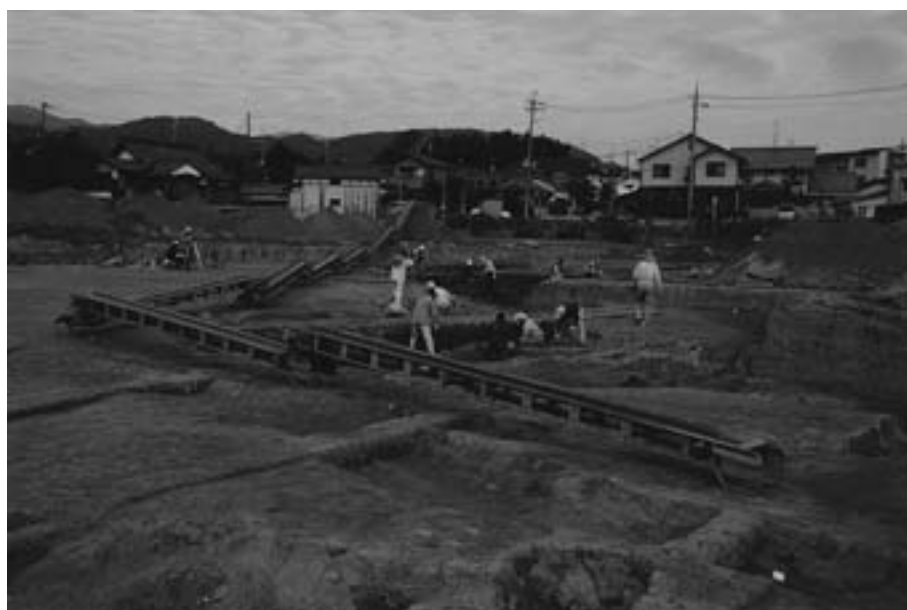
(3) 上内田地区 ＜長岡京跡右京第901次＞ 作業風景（東から）
