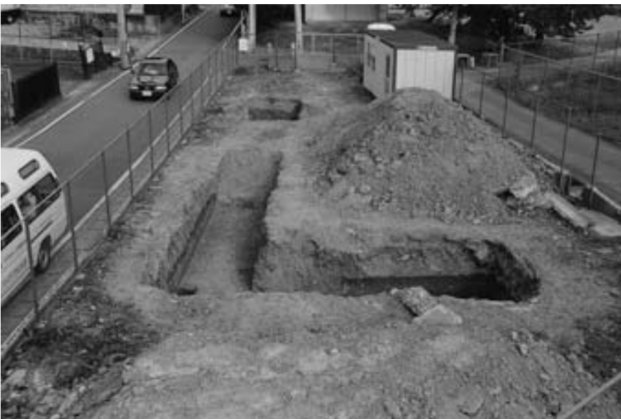
(3) 調子地区 ＜長岡京跡右京第 902 次＞ 2-1・2 トレンチ全景 （西から）
