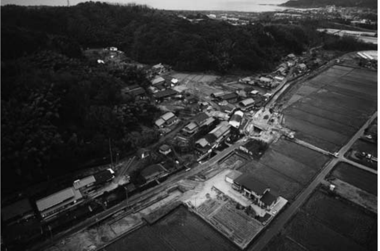
(1) 調査地遠景（南上空から）
