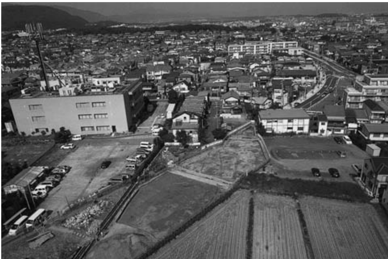
(1) 調査地全景 1～3 トレンチ(上が北)
