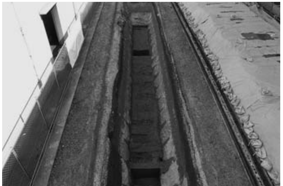
(3) 第2トレンチ全景(西から)
