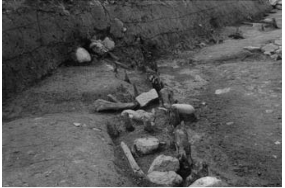
(1) 溝SD01杭列の状況(南東から)
