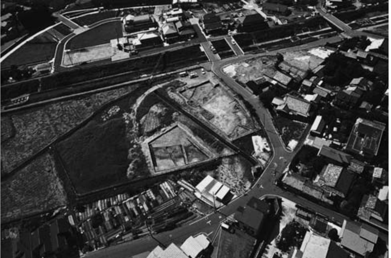
(1) 上内田地区遠景 (北東上空から)
