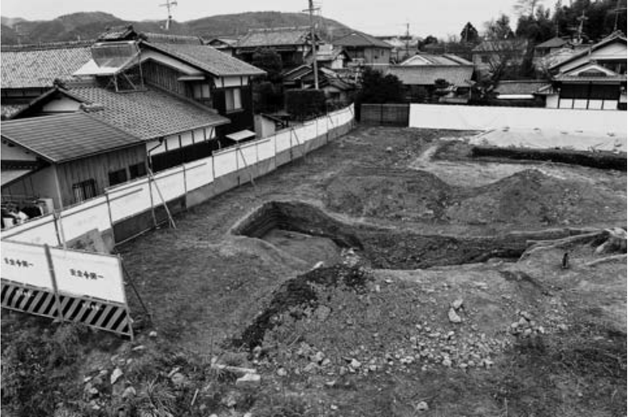
(1) 西条地区第5トレンチ・土塁状遺構全景(南東から)
