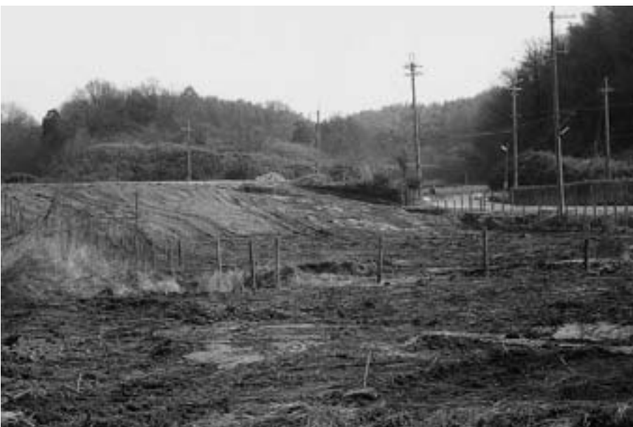
(3) 埋め戻し作業状況(北西から)
