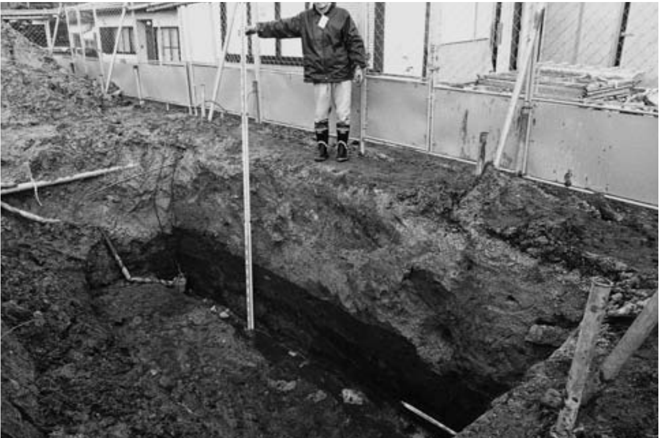
(2) 1 トレンチE 全景(南東から)
