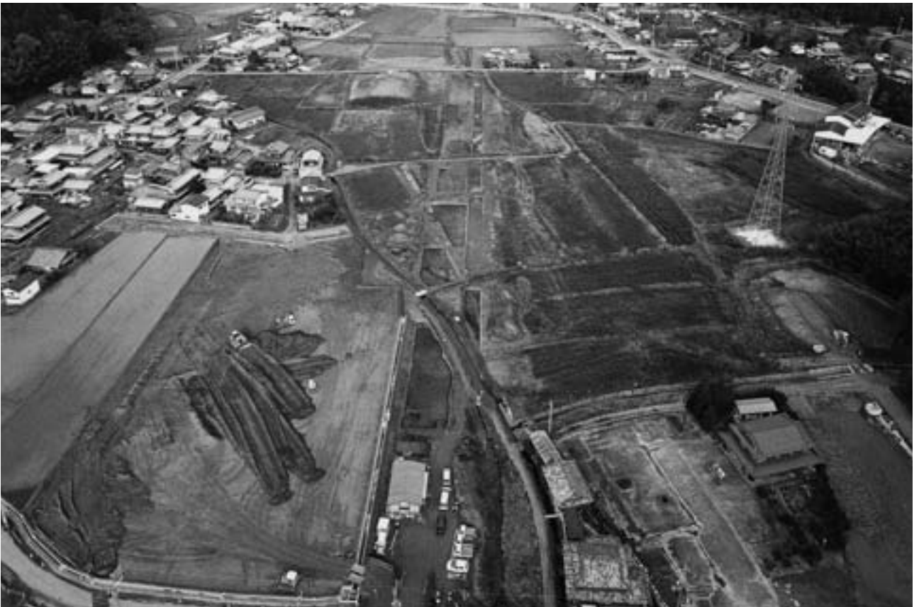
(2) 第15次調査地遠景(上が北)
