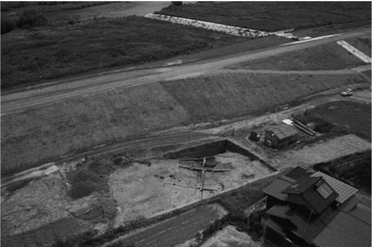
(3) 第3次1区下層調査状況(北西から)
