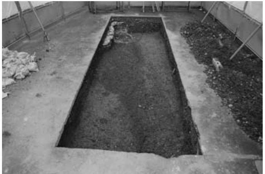
(2) 1 トレンチ全体(西から)
