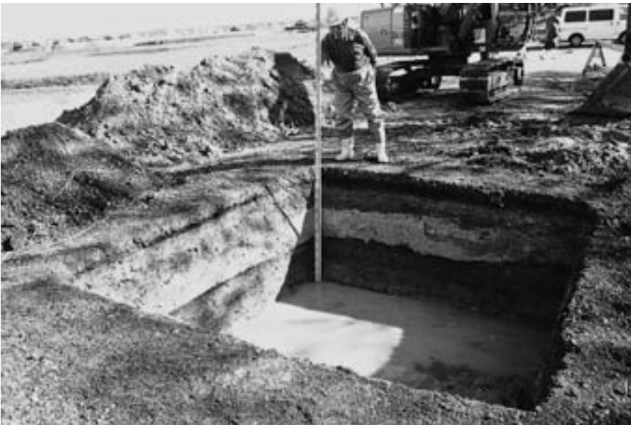
(2) G地区掘削状況(北西から)
