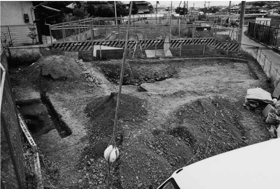
(2) 方丸地区Cトレンチ全景 (西から)
