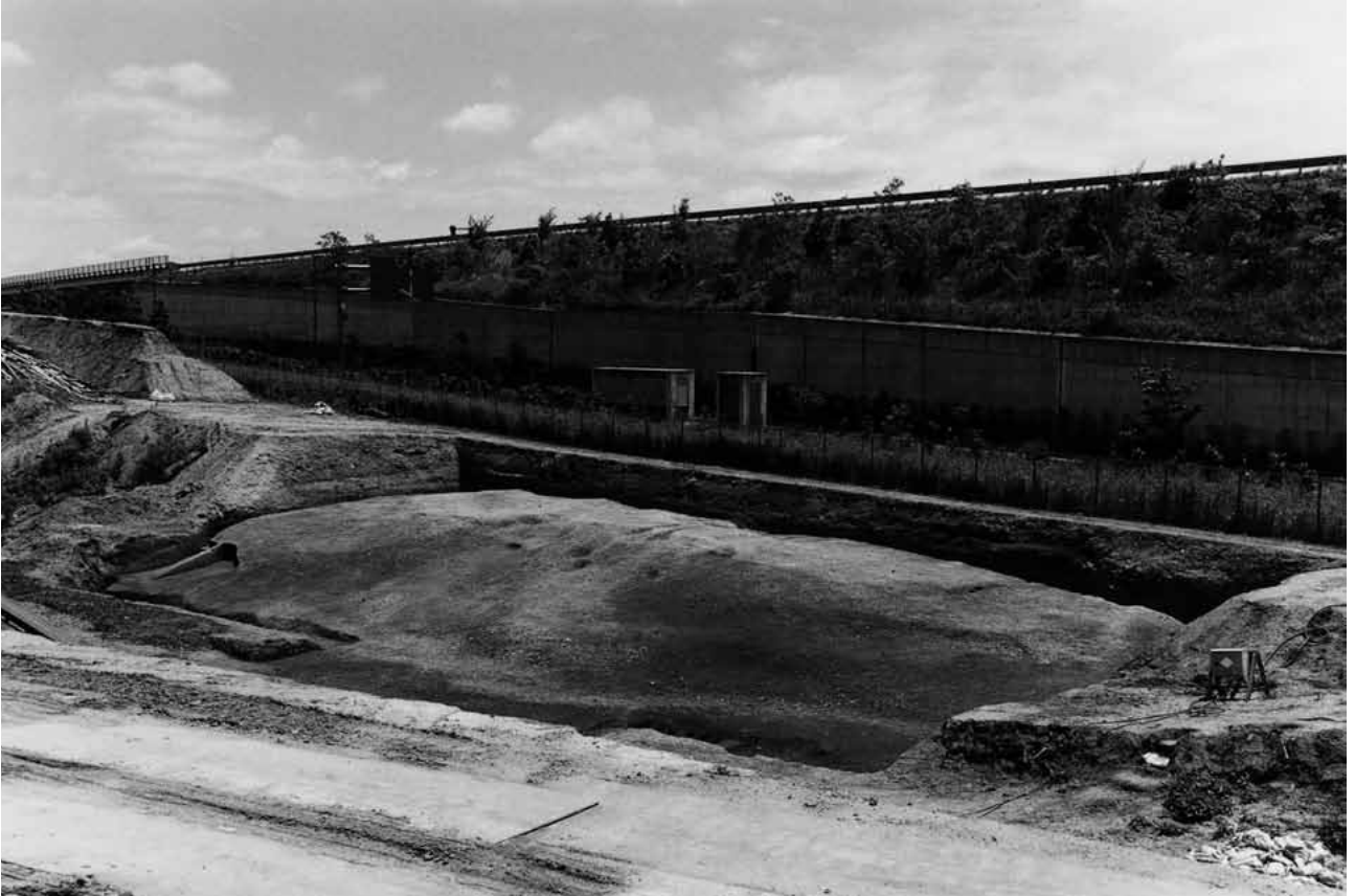
(1) 第12次調査全景(表土掘削後：南西から)
