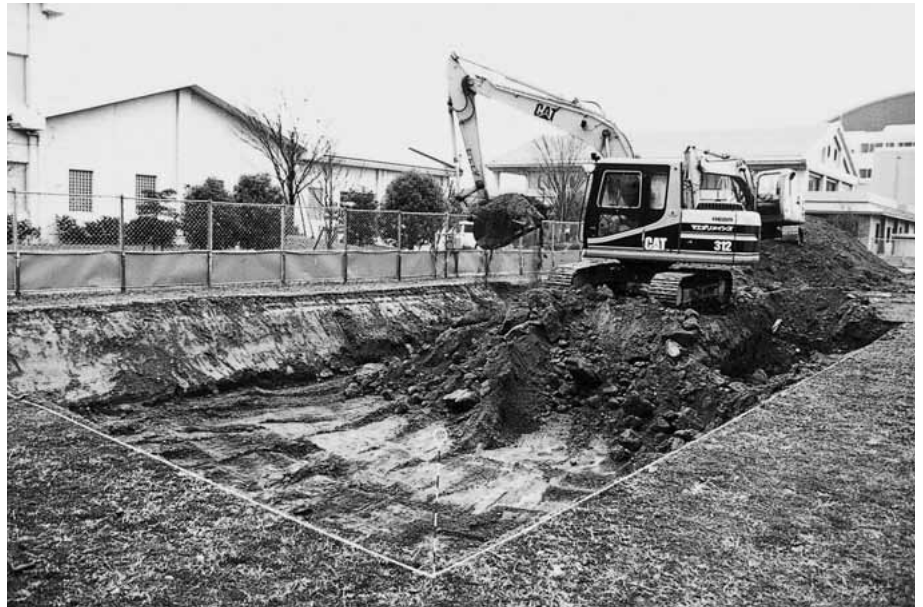
(2) Bトレンチ重機掘削(南東から)
