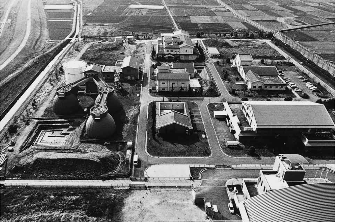
(1) 調査地遠景(北から)
