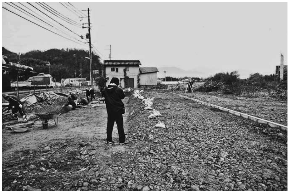
(3) 第 1 トレンチ測量状況(東から)
