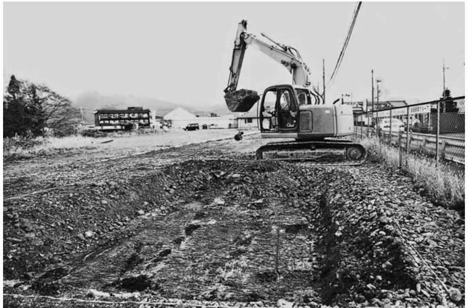
(2) 第 1 トレンチ重機掘削状況 (西から)
