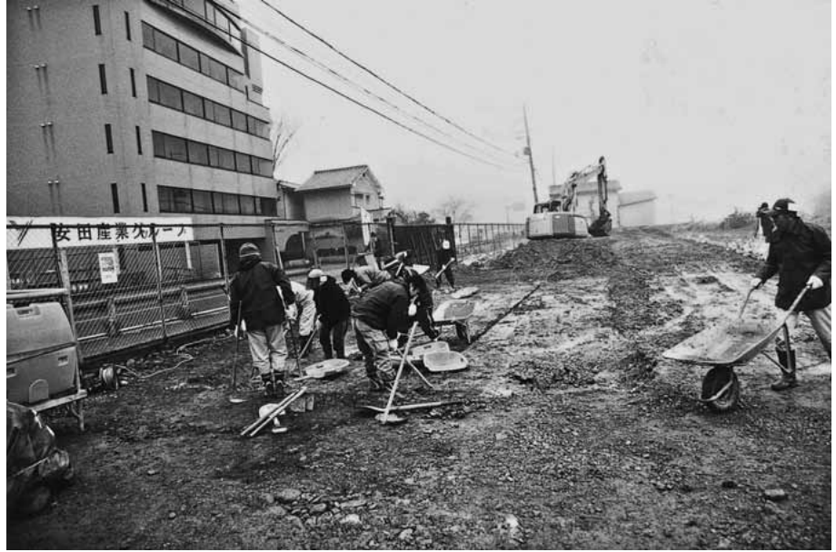
(1) 第2トレンチ荒掘り状況 (東から)
