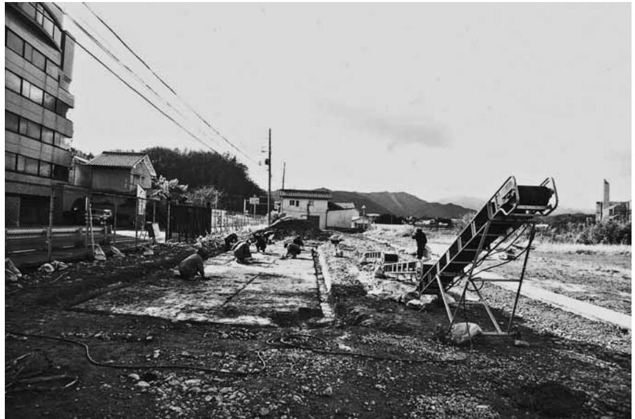
(2) 第2トレンチ遺構精査状況 (東から)
