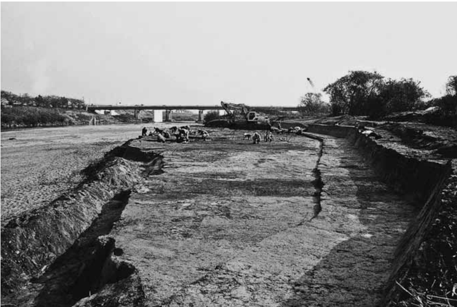
(2) 第20次調査地上層掘削状況 (西から)
