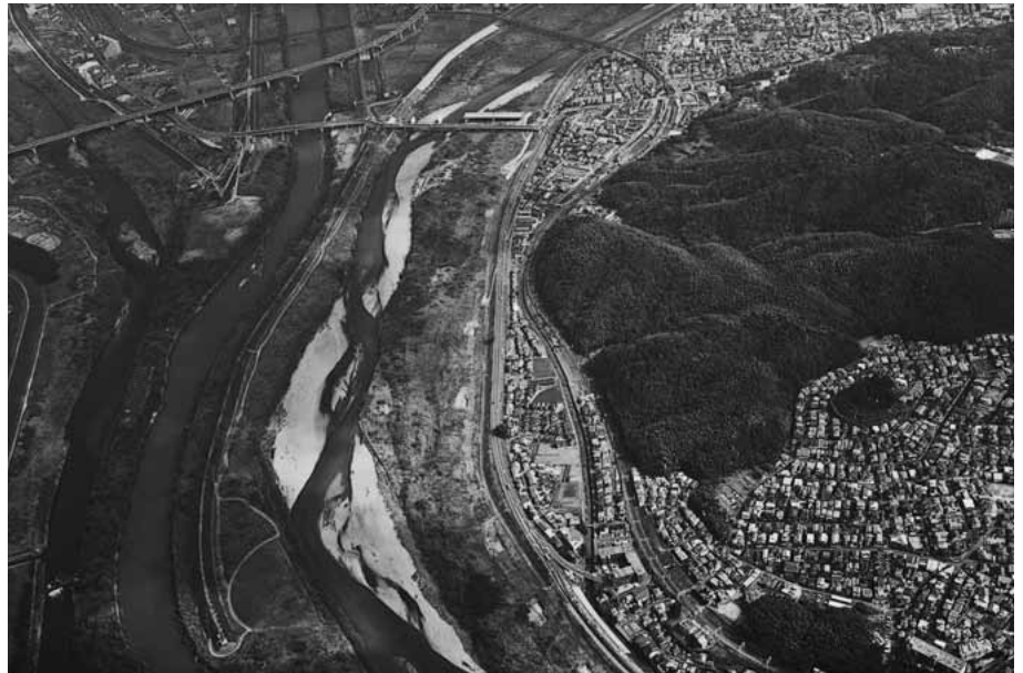
(2) 第20次調査地全景(西から)
