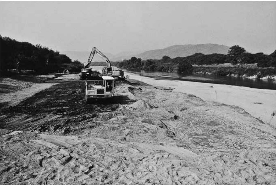
(2) 第20次調査地重機掘削状況 (東から)
