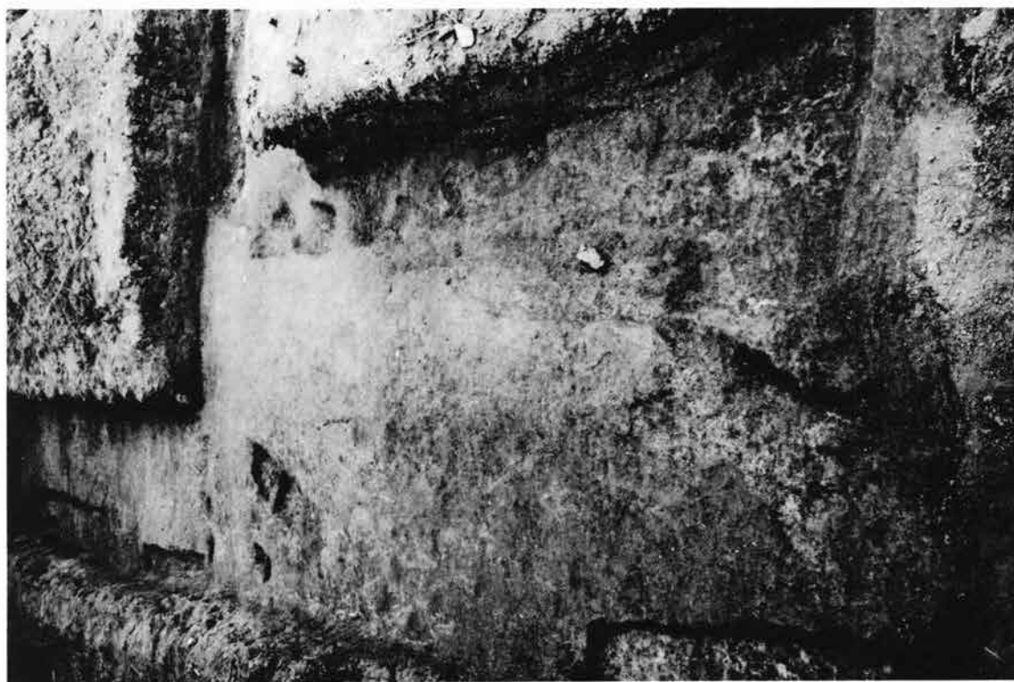
(1) A-21トレンチ (北から)
