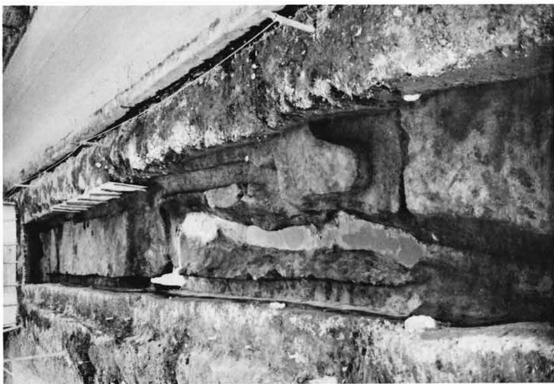
(2) No.5トレンチ全景(西から)
