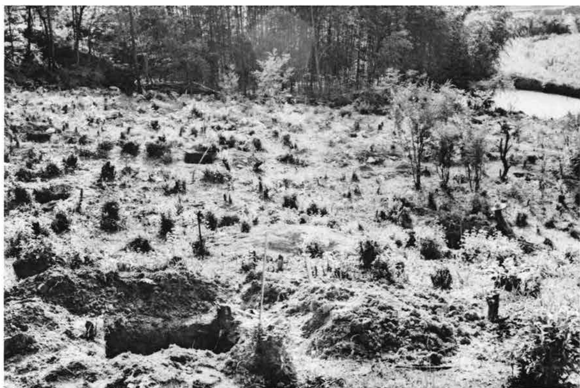
(2) 掘削状況（東南から）
