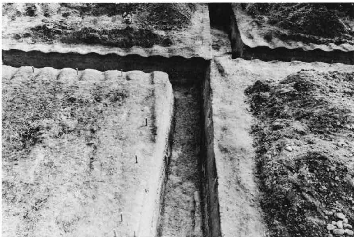
(2) 10t掘削状況（北から）
