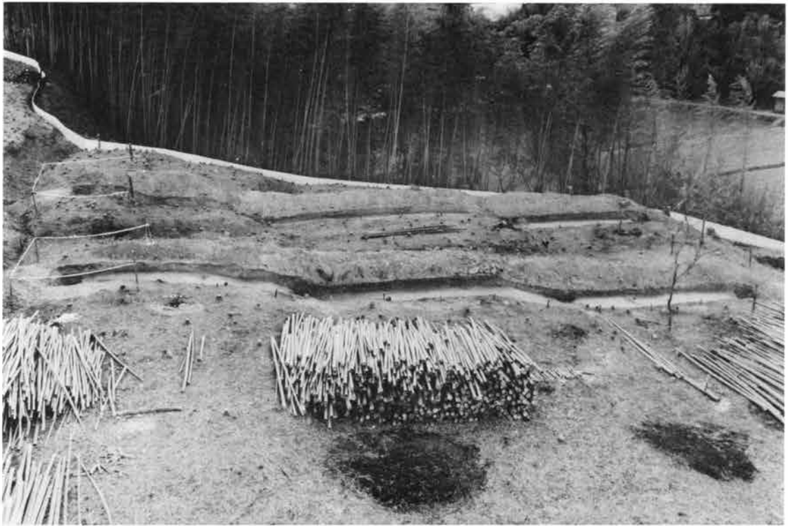
(2) 1 bt掘削状況 (北から)
