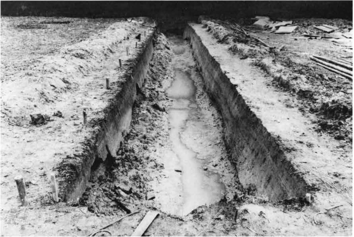
(1) 45bt掘削状況（西から）
