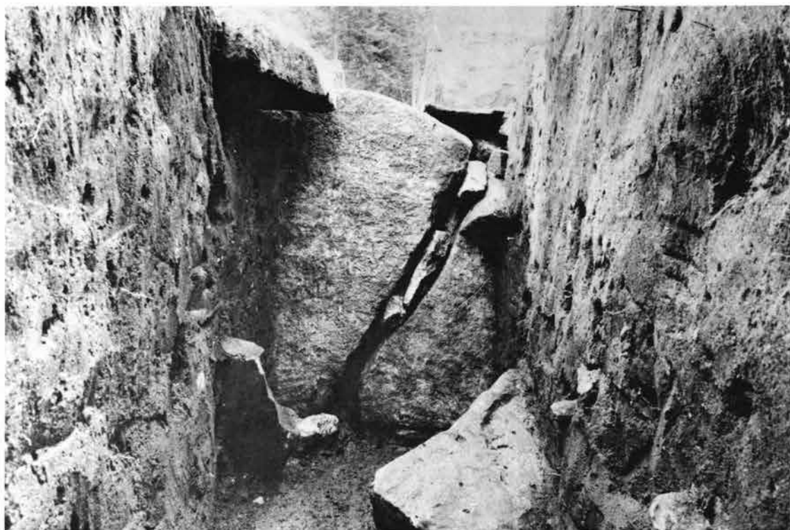
(1) 1号墳左側石背後の状況（南から）
