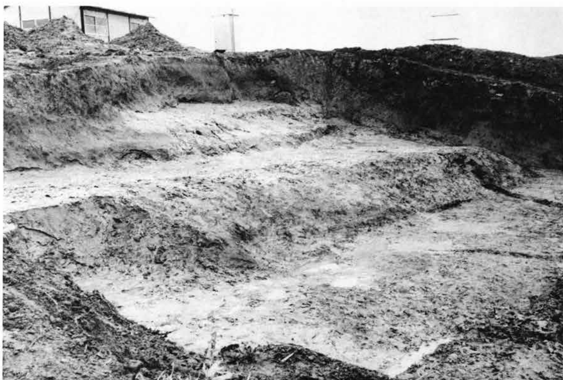
(1) B-2トレンチ (南から)
