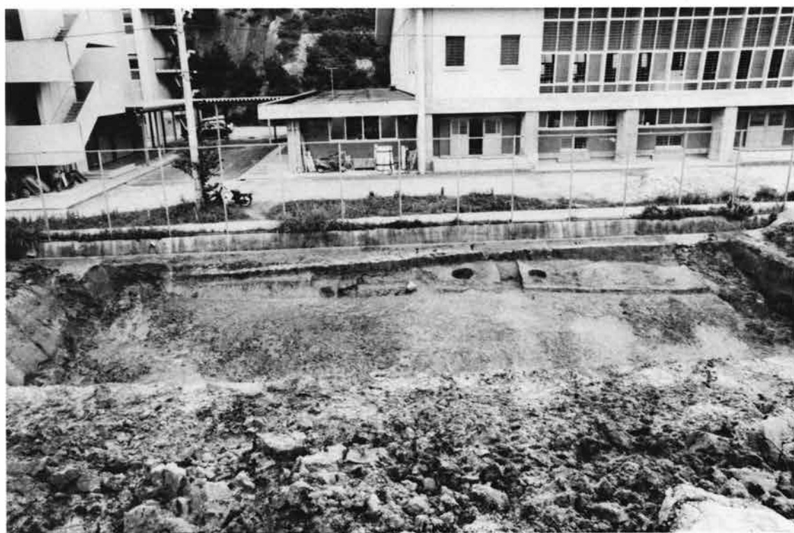
(2) 調査後全景 (東南から)
