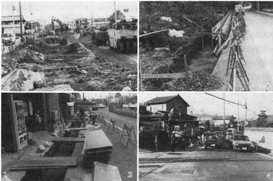
第2図 立会調査及び工事作業風景
