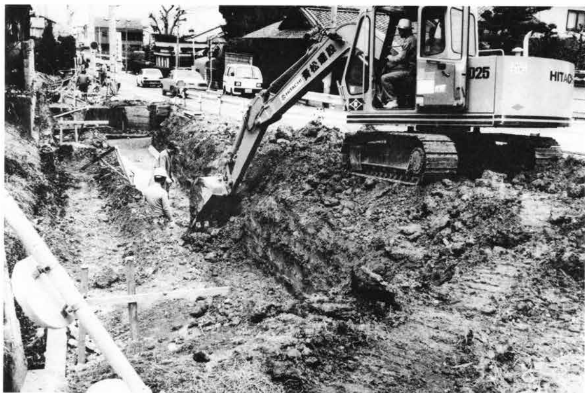
(1) 檜原高槻線(中海道遺跡)立会調査状況
