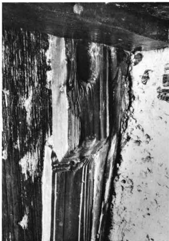
(2) 給水口 (西から)
