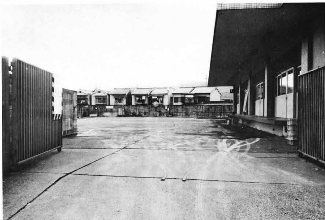
(1) 調査前全景（東から）
