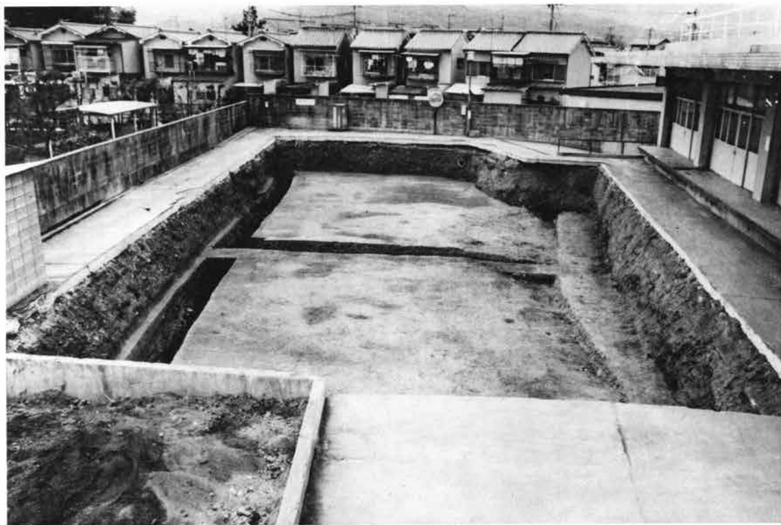
(2) トレンチ全景（東から）
