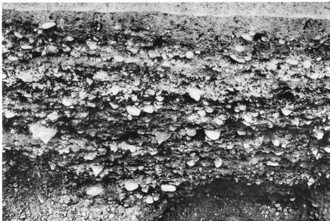
(1) トレンチ1断面 (北から)
