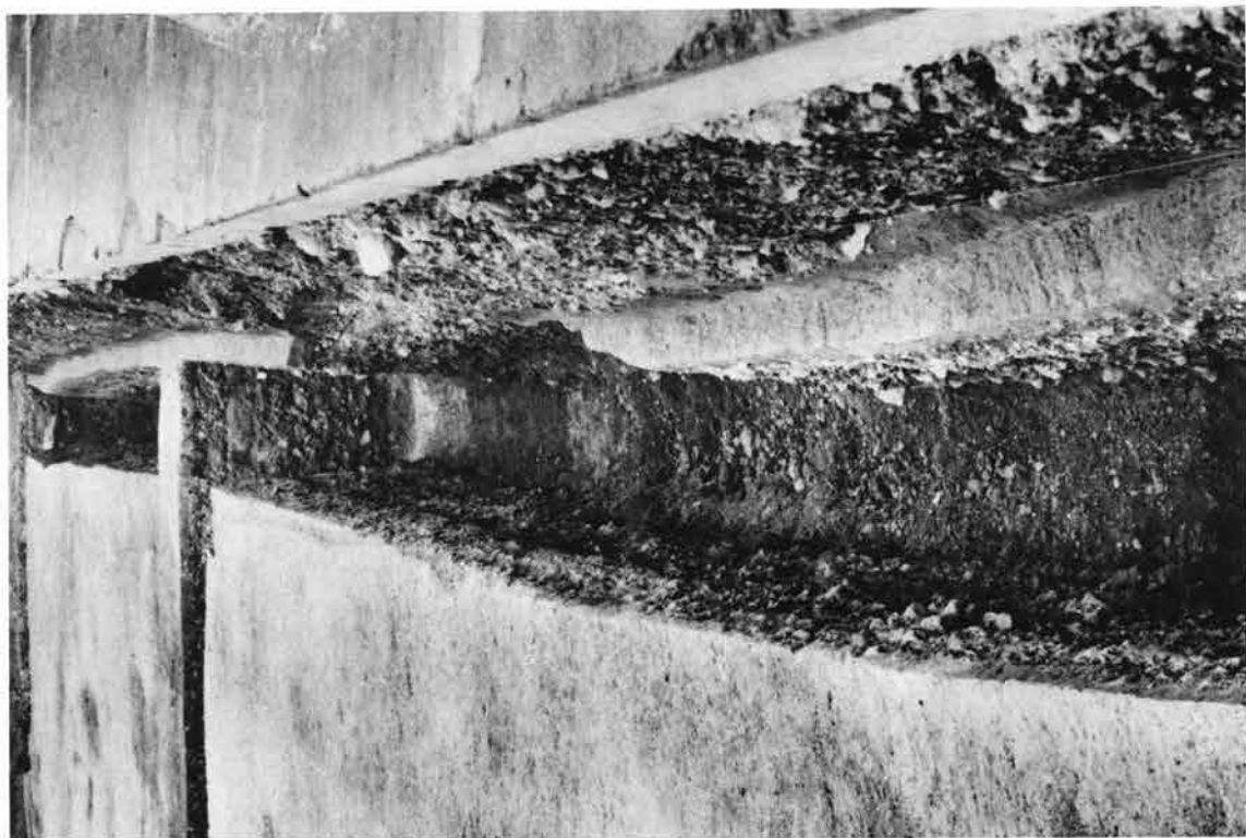
(2) トレンチ1・2・3 (西から)
