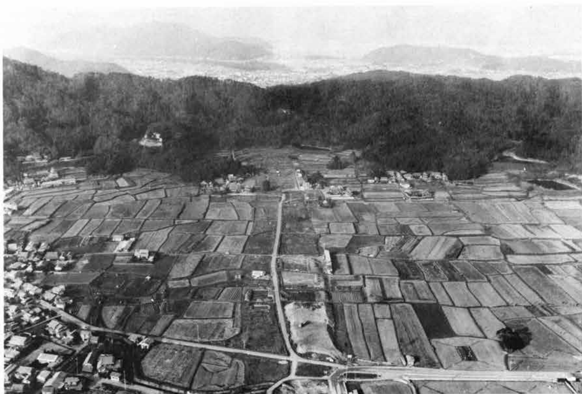
(1) 調査地遠景 (南からの空中写真)
