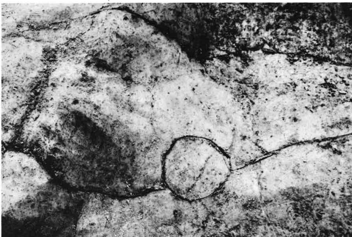
(2) 噴砂・ピット検出状況
