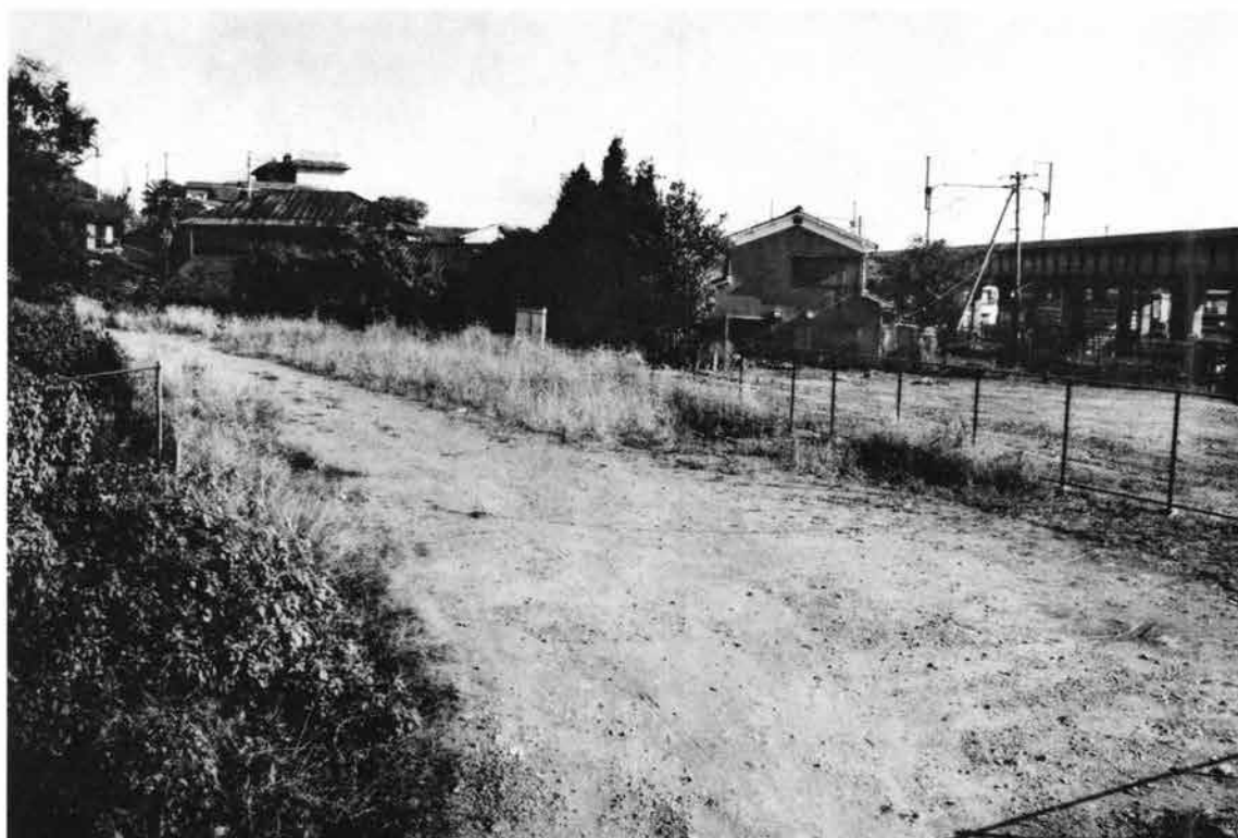
(1) 調査前風景(南東から)
