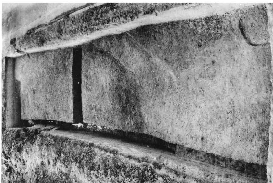
(1) Dトレンチ全景(西から)
